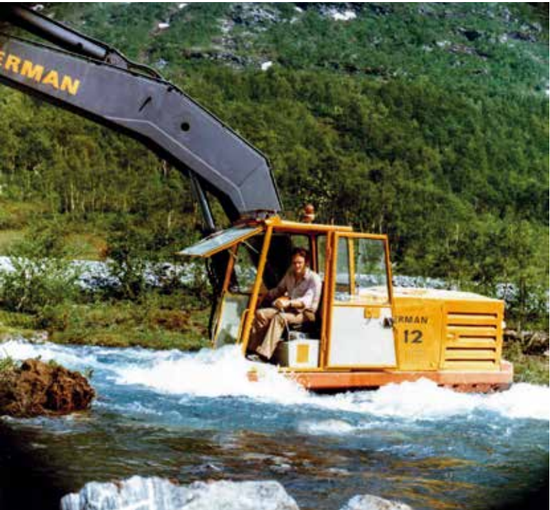
STRI STRØM: Her krysser Harry en elv i Skjerdingsdalen i forbindelse med forberedende arbeid for fundament til bro på rv. 15, Strynefjellsanlegget. Bildet er fra 1976. (Privat foto)
