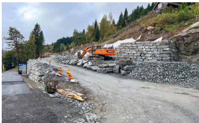
Volda Maskin utfører grunnarbeidene i forbindelse med opparbeidelsen av boligfeltet på Solvik. Her kommer det 40 boenheter. Stryn kommune er oppdragsgiver og arbeidene skal stå ferdig til sommeren 2025.
