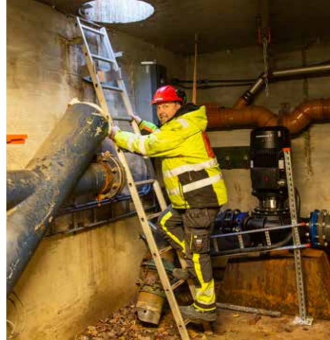
UNDER BAKKEN: Teknisk rom, som befinner seg under bakken, har vært fylt med sjøvann etter springflo. Rommet inneholder bl.a. et vannbasseng, pumper, filtre, rør og komponenter, og det meste skal byttes ut, forteller anleggsleder Svein Kildal.
