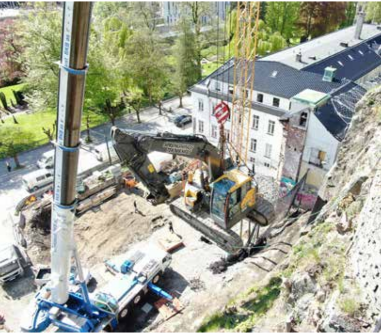
OPP: I mai ble utstyret heist opp på hylla med en 250 tonns mobilkran. Fem måneder senere var det nede på bakkenivå igjen. (Dronefoto: Gordon Rosten)
