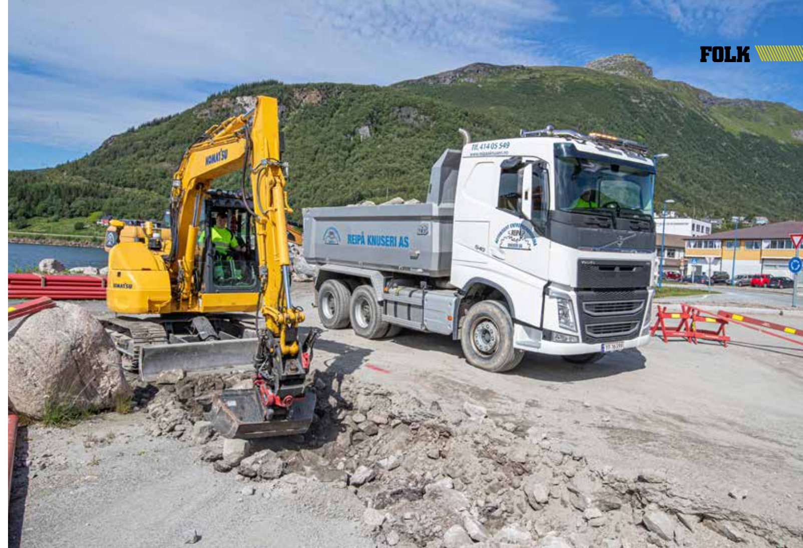
KABELGRØFT: Timo Svendsgård graver kabelgrøft i Reipå og laster på hos Liv Marie Freding Sletvold.
