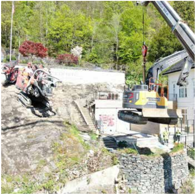
PLASS: Det var akkurat plass nok til å lande graveren, mens boreriggen ble sikret på berget med vinsjen. (Dronefoto: Gordon Rosten)
