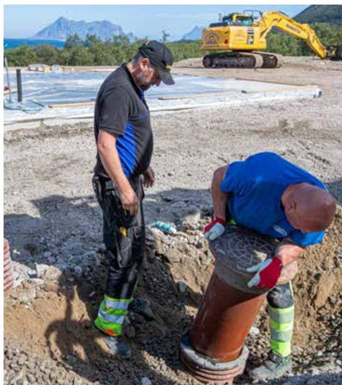
Rørlegger Tormod Martinussen og maskinfører Jan Kenneth Svendsgård i arbeid på en tomt nær Reipå.
