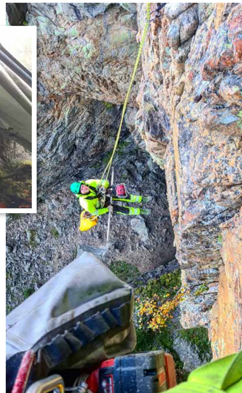
HÅNDARBEID: All løs stein ble tatt ned. Dette er klatrer Øystein Åsbakk.
