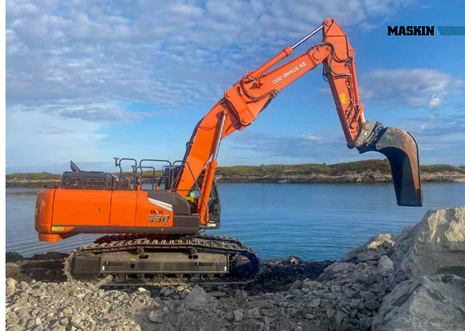
VANLIG: Fem minutter tar det å bytte mellom standard (bildet) og langt graveutstyr. (Foto: Odd Småge AS)
