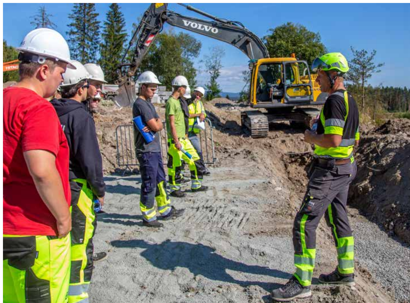
RISIKO VED GRØFTEGRAVING: Opplæringskonsulent i OKAB, Benny Engelstad, viste og forklarte elevene om risiko ved grøftearbeid.
