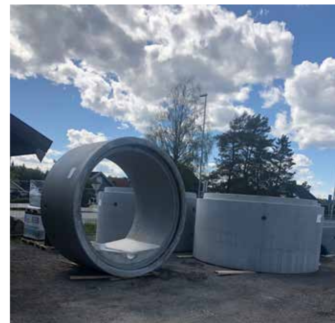
MYE BETONGVARER: Det meste standard prefabrikkert. Ringene til tankene (bildet) fikk en istøpt renne til sumpen. (Foto: Nordre Follo kommune)
