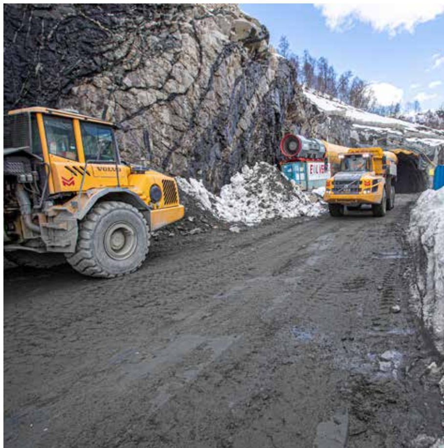
FRAMDRIFT: Tunnelen drives fra begge ender. Dette er munningen nærmest Geiranger, inne i det følsomme verdensarvområdet.
