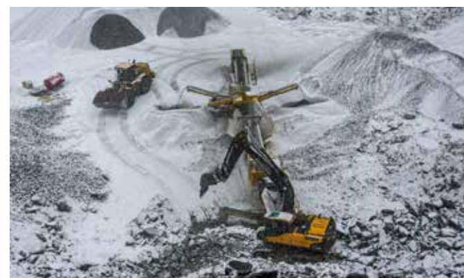
KNUSING: Totalt 62 000 m 3 masser skal sprenges ut fra tunnelen, som har et tunneltverrsnitt er på 22 m 2 . Bedriften har en grovknuser og en finknuser på området, og mye av massene brukes i prosjektet.
