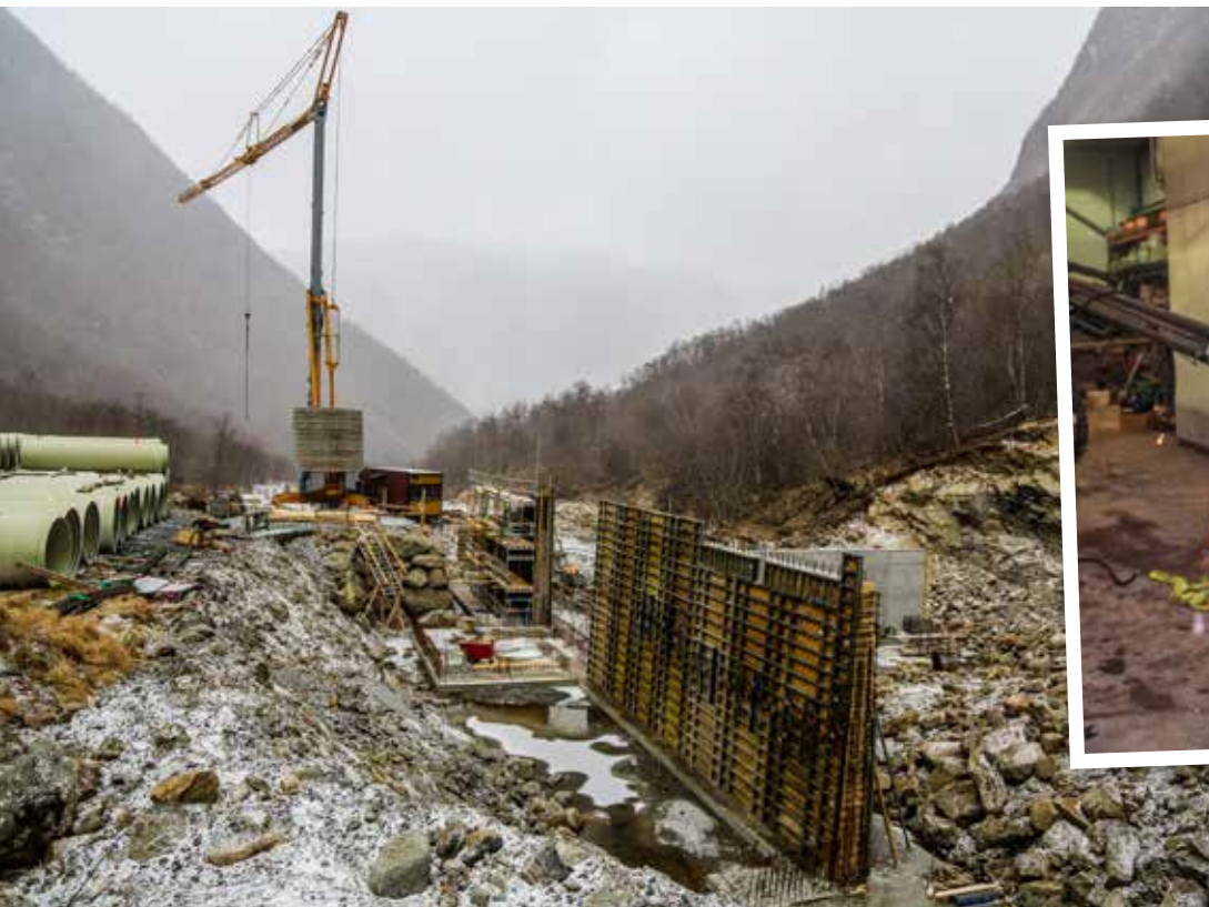
BETONGARBEIDER: Det blir gjerne en del betongarbeider på kraftverksprosjekter. Da er det greit med et eget betongselskap. Her fra inntaket til Fosseteigen kraftverk.
