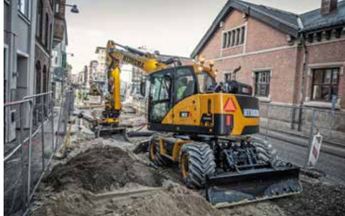
BYGRAVER: Med en maksimal hastighet på 35 km/t kan Hydremas serie med MX-hjulgravere bevege seg hurtig mellom byggeplasser. Også i travle byområder med minimal plass. (Foto: Hydrema).
