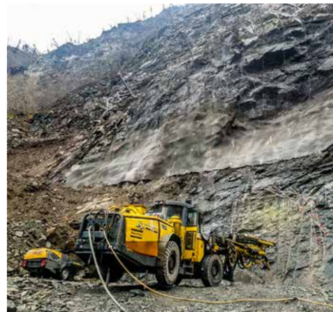
FORBOLTING: Det måtte gjøres mye forarbeider, før de kunne komme i gang med tunnelen; både omfattende fjellrensk og forbolting/spiling, som foregår her. (Foto: Ottar Dvergsdal AS).
