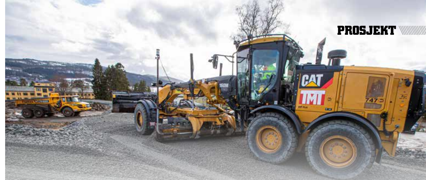
KONTRAKT: Tverås Maskin og transport AS er HE på grunnarbeid på prosjektet med nytt akuttssykehus for Nordmøre og Romsdal.
