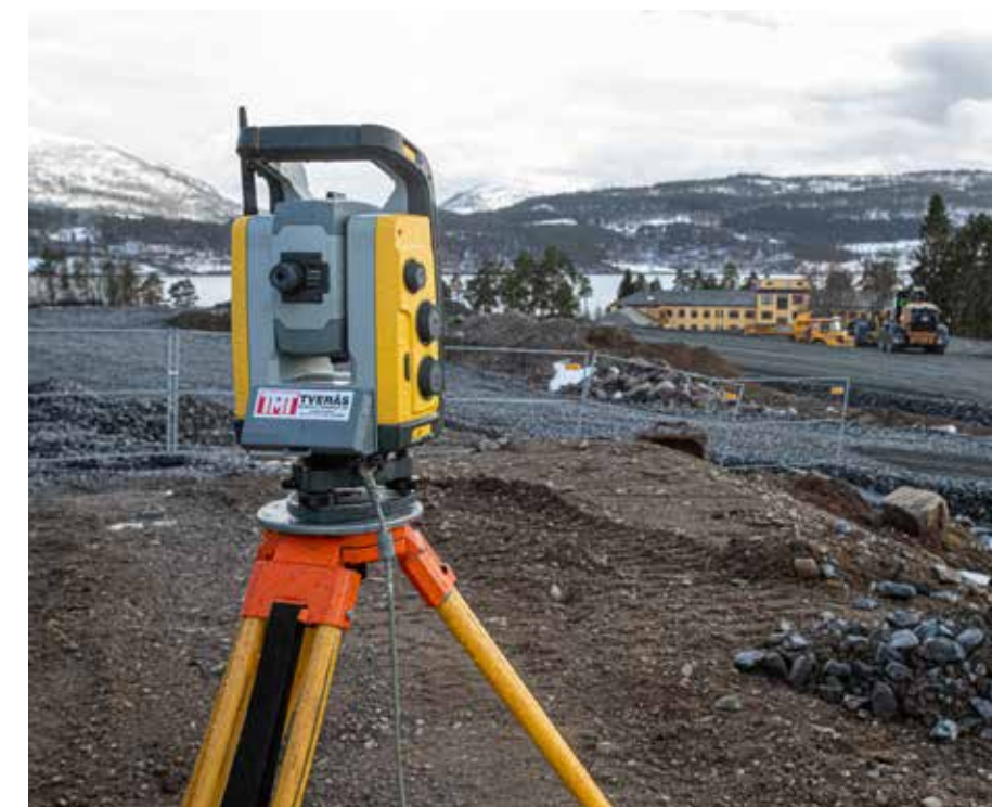
HØVLER: Forberedende arbeider ble avsluttet i april. Grunnarbeidet starter i juni.
