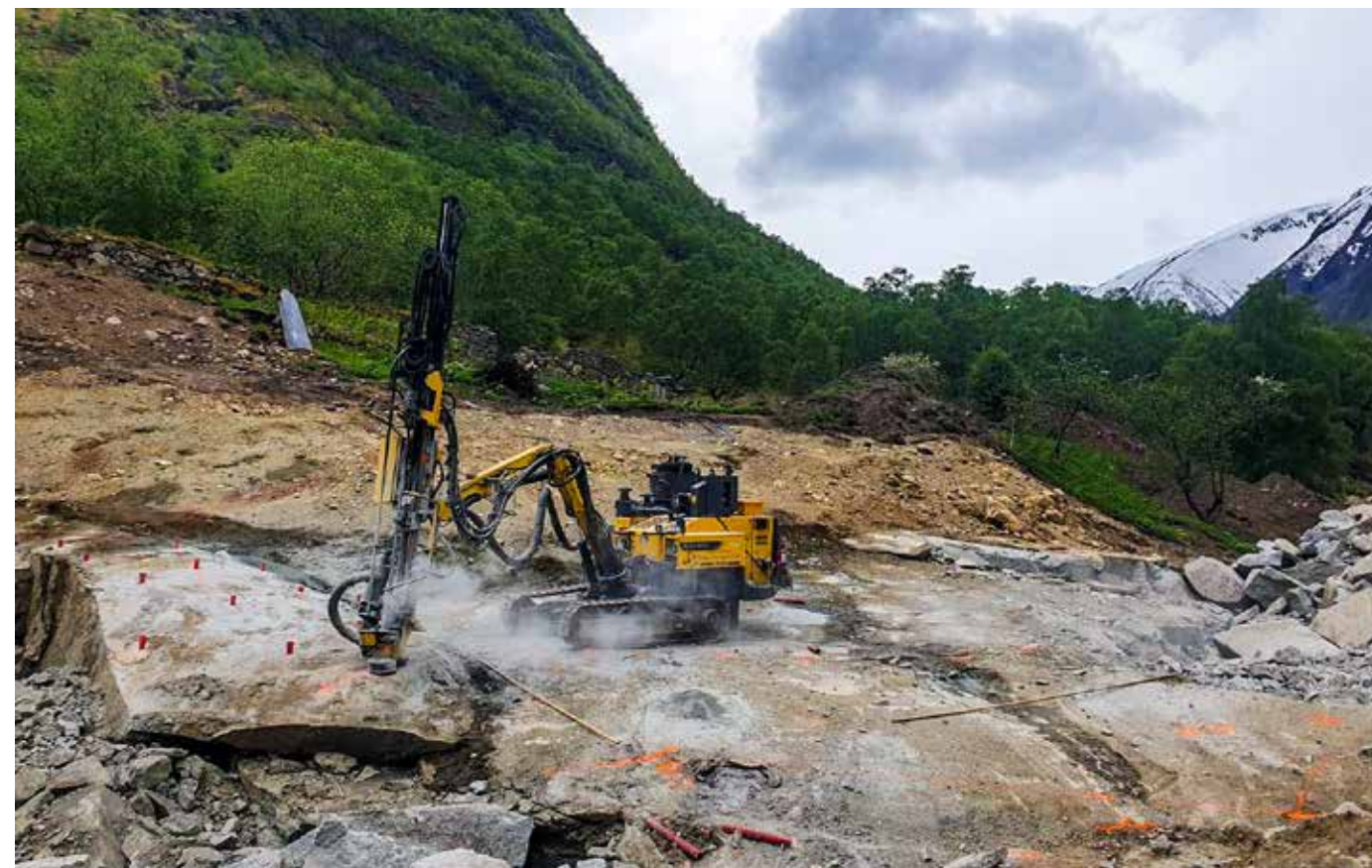
DREVNE PÅ KRAFTVERK: Totalt har jølsterbedriften bygd 32 kraftverk, og ytterligere seks er godt i gang – i tillegg til en del andre, tradisjonelle anleggsjobber. (Foto: Ottar Dvergsdal AS).
