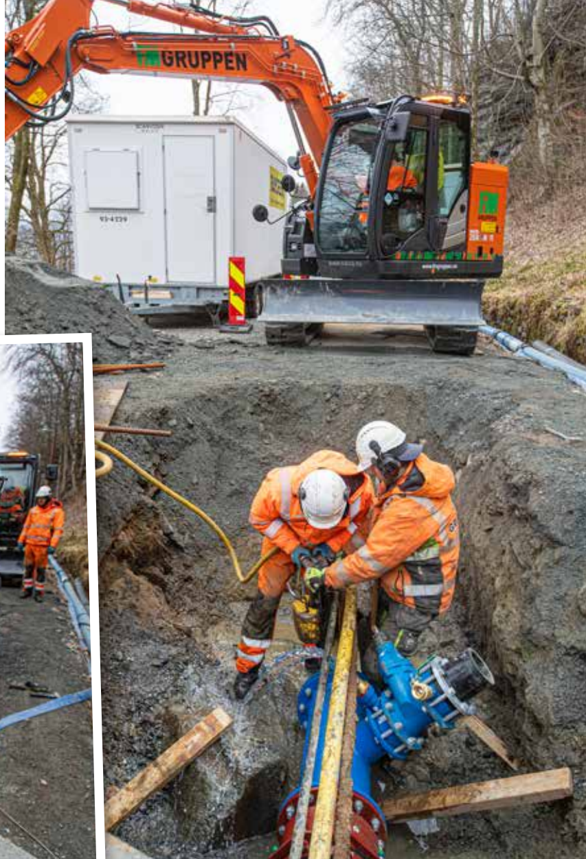
STØY: Håndholdt boring støyer infernalsk. Fra gravemaskinen hører man kun lyden av hydraulikkpumpa. Maskinfører og håndmann kan snakke normalt sammen (når det ikke bores).
