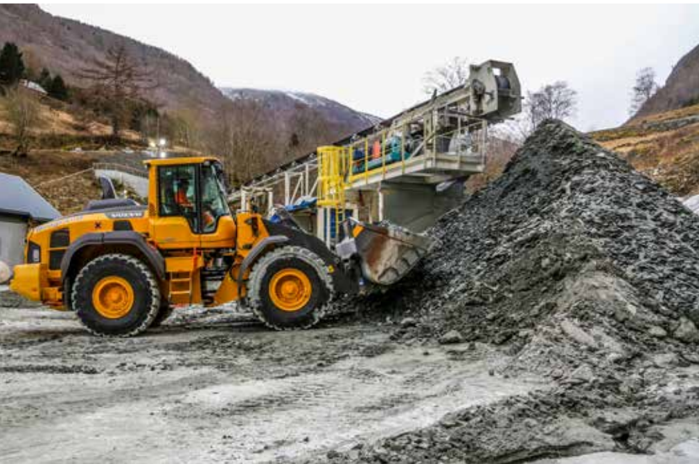
MYE FINMATERIALE: Tunnelmassene (de kalles chips, på grunn av formen – nesten som mangokjerner) har en størrelse mellom 0 og 120 mm. Det er imidlertid mye finmateriale i massene, som kan være vanskelig å utnytte. Totalt skal ca. 30 000 kubikk steinmasser fraktes ut av fjellet (ved hjelp av transportbåndet) og kjøres til et midlertidig depot.
