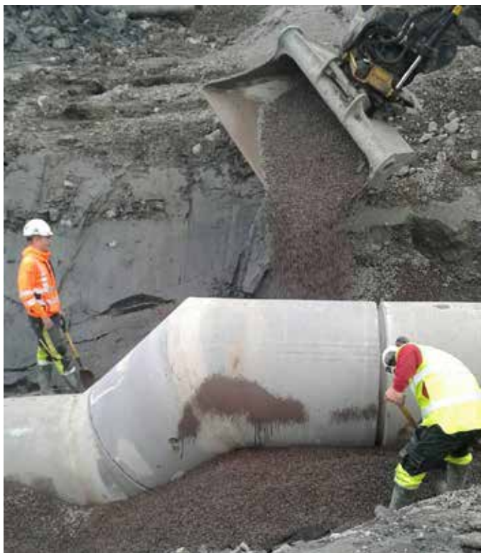
OVERVANNSHÅNDTERING: Kjeldaas AS under en tradisjonell løsning for overvannshåndtering. På oppdrag av Norsk Jernbanedrift ble et rørstrekk for en bekk oppgradert i størrelse.
