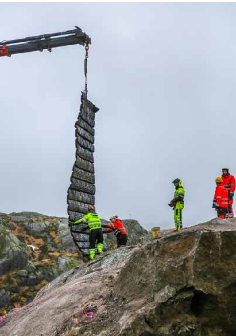
SPRENGING: Det skal totalt sprenges ut 90 000 kubikk faste masser på området. Alt som sprenges blir brukt internt på prosjektet.
