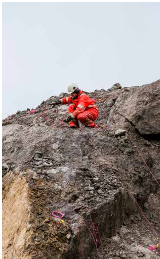
SPRENGING: Det skal totalt sprenges ut 90 000 kubikk faste masser på området. Alt som sprenges blir brukt internt på prosjektet.
