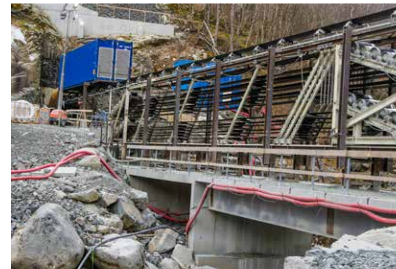
«TREKKSPILL»: Den spesielle konstruksjonen med «kassetter» for transportbånd, står på ei midlertidig bru like utenfor tunnelåpningen. Dette «trekkspillet» mater ut transportbånd etter hvert som Snøhvit spiser seg innover i fjellet.
