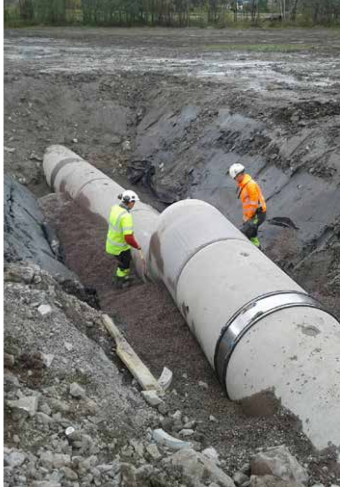
BEKKELUKKING: Fortsatt ledes betydelige overvannsmengder i rør, men blågrønne-løsninger er på full fart inn. Her fra en bekkelukking Kjeldaas utførte.
