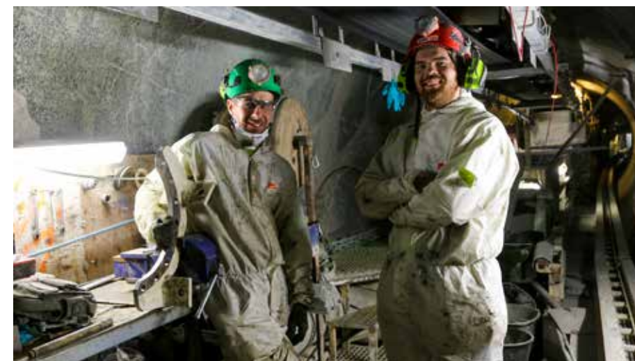
VEDLIKEHOLD: I en av TBM-vognene dukker det opp to småbleke menn i hvite drakter. Det viser seg å være mekaniker Christopher Alsford og elektriker Olav Meyer Torstveit, som utfører vedlikeholdsarbeider på dette 12-timersskiftet.
