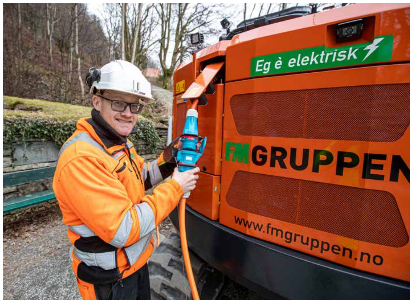
MASKINFØRER: Rune Vikanes har tidligere kjørt mye større maskiner. Nå er han testpilot på en av to Zeron ZE85 el-gravere i Fyllingen Maskin.
