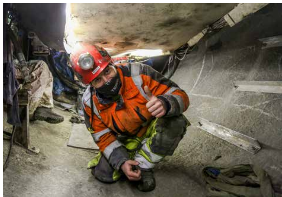
TRANGT: Produksjonsleder Maciej Rodykow trives svært godt med TBM-boring, selv om det kan være trangt å bevege seg på Snøhvit's langstrakte kropp. Her, helt framme ved borhodet, må han ned i knestående for å komme fram.
