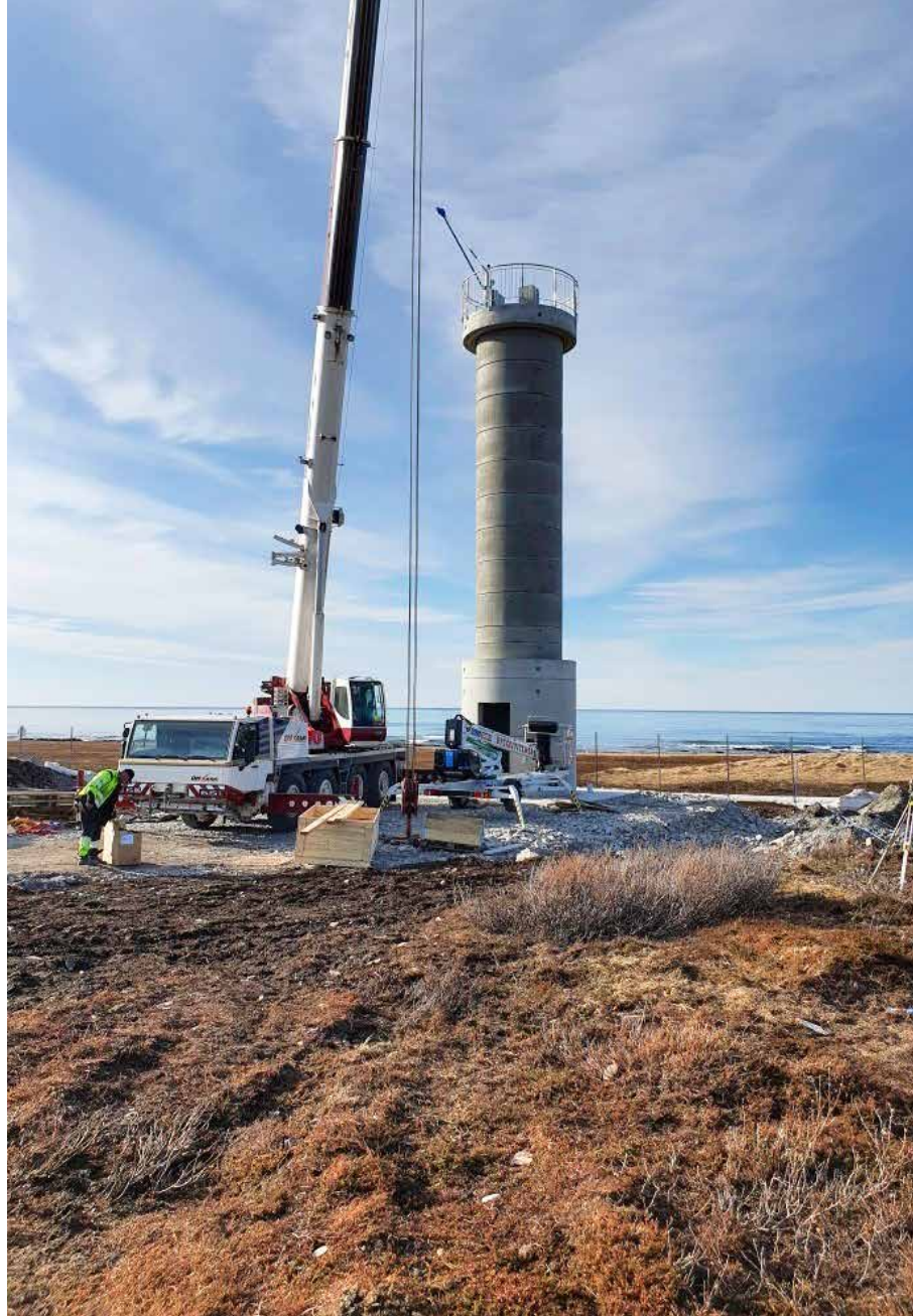
MONTERING: Loe prosjekterer og lager elementene. Her blir de montert av Jaro AS på flyplassen i Berlevåg.
