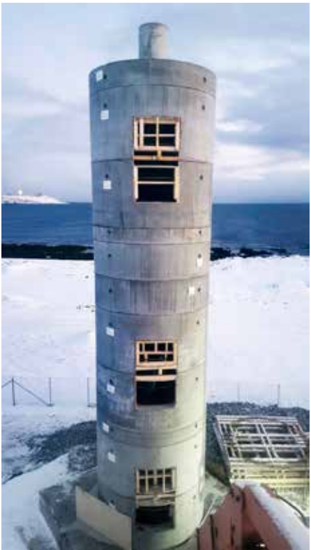
KLART: Betongelementer ferdig montert.
