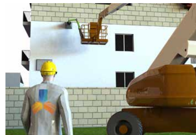
PROSJEKT: Malermestrenes Landsforbund er med i et prosjekt for å teste ut effekten av å bruke robotlift for vasking og maling av større bygninger.
