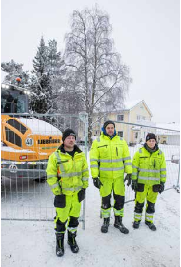
INNSATS: F.v. Simen Totlund, Thomas Olafsen og Modestas Zavadskis har hatt mange lange dager i Gjerdrum. Thomas kjører vanligvis en Liebherr 14 tonnshjulgraver, Modestas en Doosan 225 beltegraver og Simen er grunnarbeider for Thomas. Her i Gjerdrum er det alle mann i alle slags oppgaver. – Veldig stille og veldig mørkt den første morgenen. Vi holdt på på baksiden, ikke i nærheten av brannfolk og redningsarbeid, sier Thomas Olafsen. (Foto: Jørn Søderholm)
