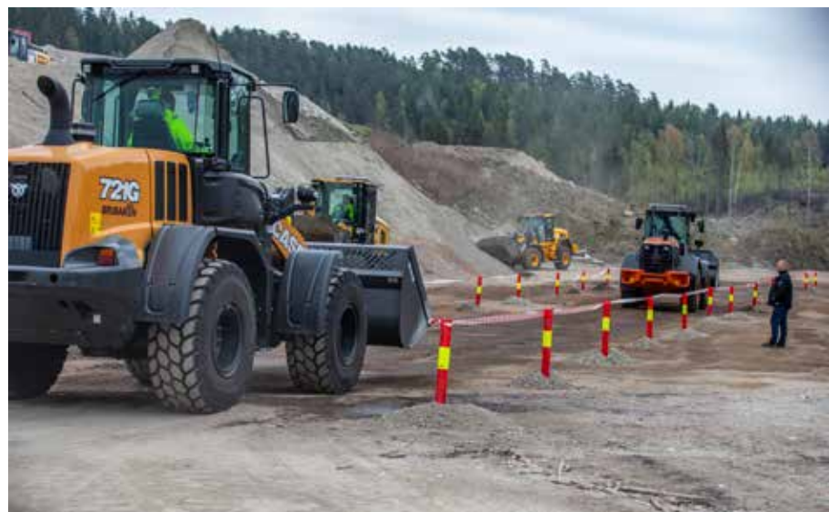
ANLEGG: Massehåndteringsanlegget i Oredalen ble grundig tilrettelagt for testen.
