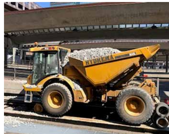
FULL: Hydrema-dumperen begynte å trille under lastning. (Foto: Baneservice)
