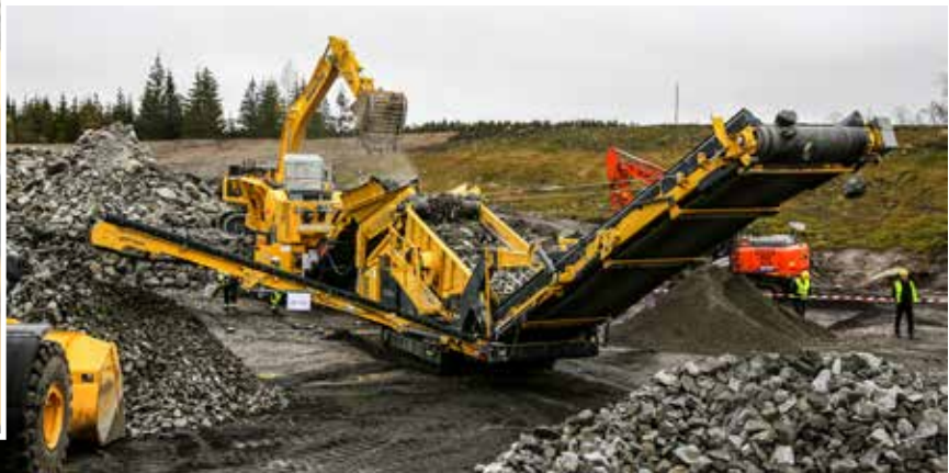
VERK: Keestrack-kjefteknuseren K7e og sikteverket K7e i aksjon.
