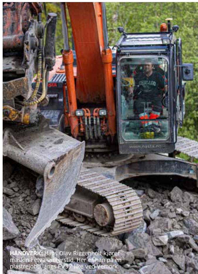
PLASTRER: Skårberg Maskin plastrer fjellsida ved Vemork. Stabilisering av tre store fjellskråninger over veien, på oppdrag for NCC.
