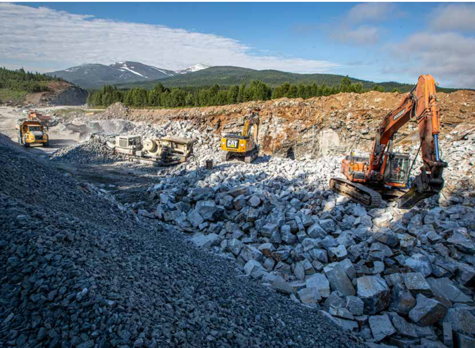
TIDSPRESS: Kapskarmo-Svenningselv på E6 Helgeland Sør har høyt tidspress på seg. Bildet ble tatt midt i juli. Tre uker etter ble det lagt asfaltert bærelag her.
