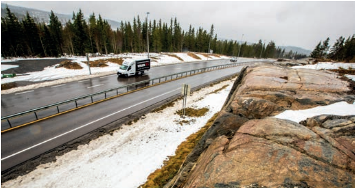
SKJÆRING: Volumet var det samme, men med bare halvparten av gjennomsnittlig pallhøyde. Dermed skjøt sprengningskostnadene i været. Dette er en av de høyeste skjæringene i prosjektet.
