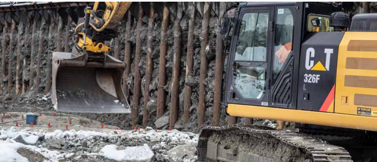
SPRENGSTOFF: Her er Tore Torp i arbeid på en tomt for Coop. Det nye SVV-kravet gjelder kommende veikonstrakter.
