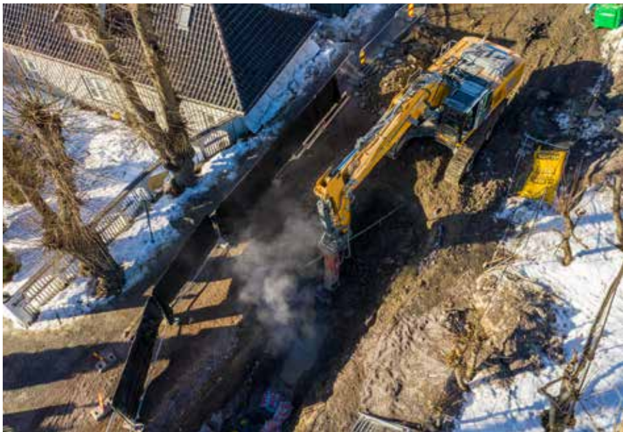
PIGGING: 60 tonn Liebherr må inn for å pigge i hardt berg i Drammen.
