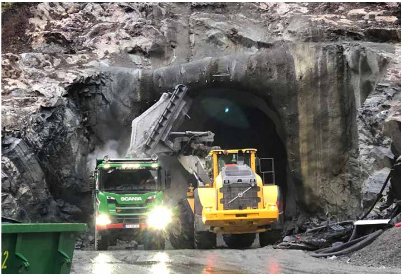
LASTING: Lasting i tunnelen foregår med Volvo 220 og en Schaeff graver.
