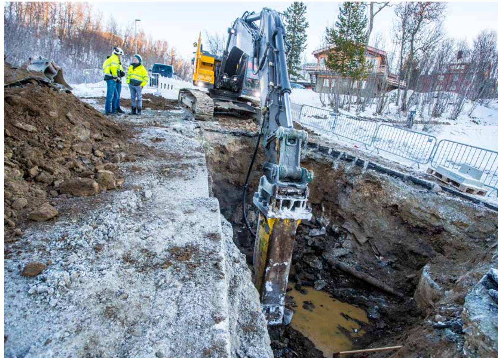
GRØFTEKANT: Her er anleggsleder Per Einar Sandvik i Grav & Spreng AS i samtale med VA-prosjektleder Knut Strand i Tromsø kommune. Prosjektet ble gjennomført vinteren 2017. Firma eller personer på bildet er ikke omtalt i saken. (ARKIVFOTO: JØRN SØDERHOLM)
