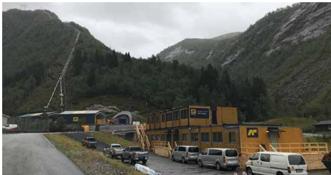
RIGG: AF er hovedentreprenør for Statkraft, med Per A. Øren AS som UE.
