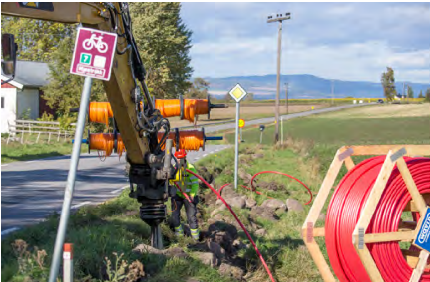
KABEL: Veflen graver mye kabel. Her et fiberprosjekt med spesielt utstyr i Stange, Hedmark.
