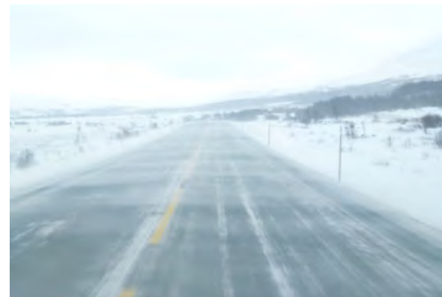
VÆRHARDT: Det er mye vind og snøfokk på Dovrefjell. Foto: Steinar Svensbakken, Statens vegvesen.
