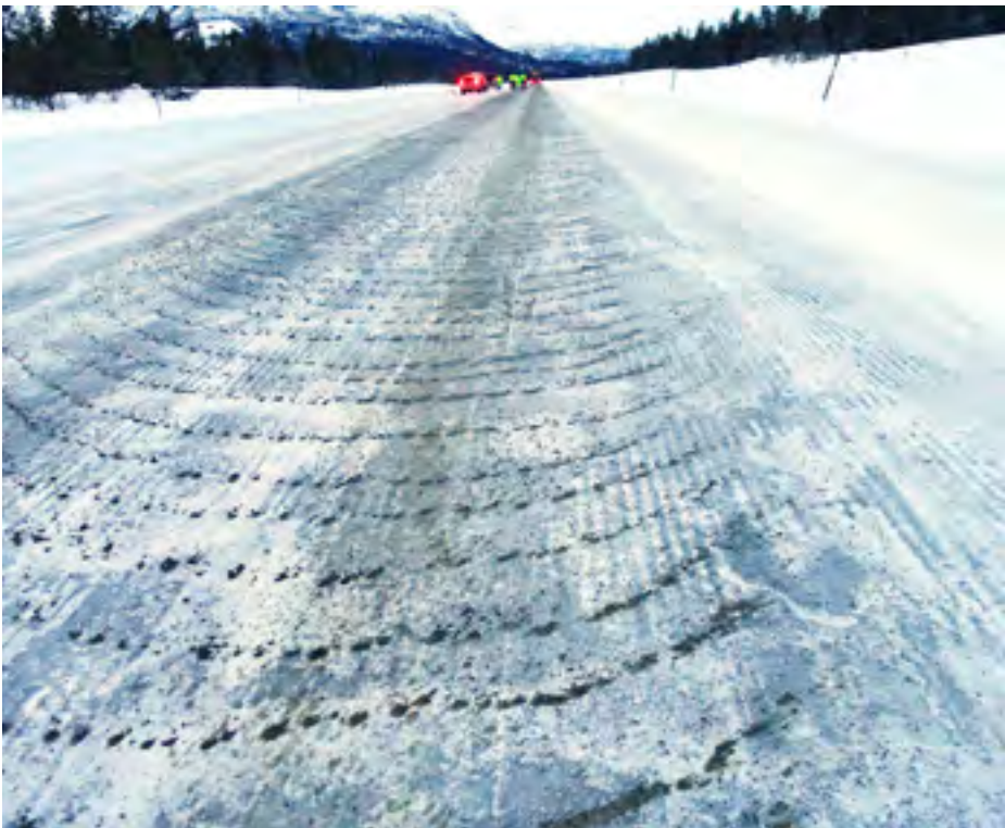
FRIKSJON: Her er fastsand kjørt ut på Bjorli. (FOTO: VEGDIREKTORATET)
