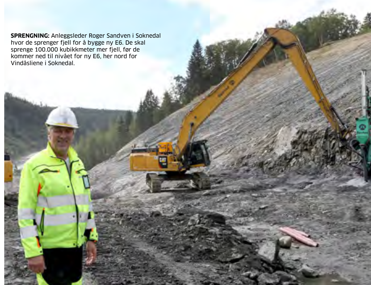
LØSMASSE: Jordnagling for å holde løsmassene på plass inntil fjellsiden. Seierstad Pelemaskiner AS utfører dette for AF Gruppen.
