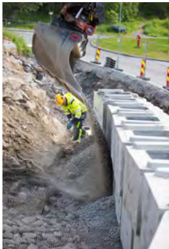
DRENERING: Blokkene fylles med pukk inni og bak for drenering.
