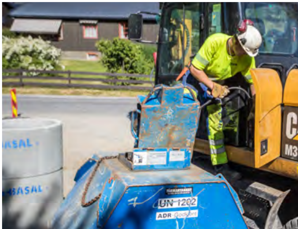
HJULGRAVER: – Jeg liker det varierte arbeidet i hjulgraveren, sier lærling Sigurd Berge. Han går opp til fagprøve i vei- og anleggsfaget nå etter sommeren en gang. Sveiser rør gjør han også.
