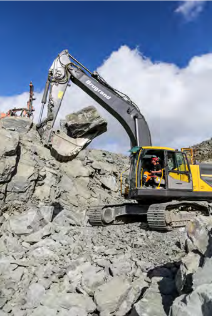
STORE STEINER: En av utfordringene, både på dette og de andre damprosjektene Oskar Brugrand AS har utført, er å produsere de store steinene, over 1 kubikkmeter i volum. Steinen tas ut fra dette dagbruddet like ved dammen.
