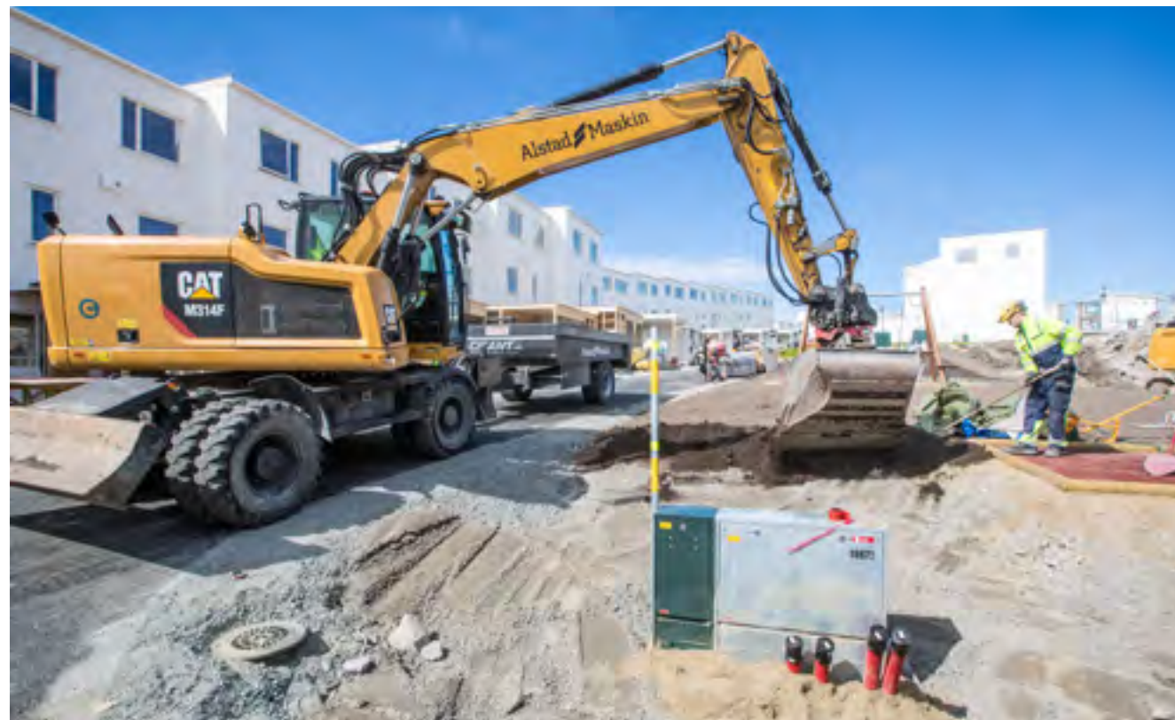
PROSJEKTET: Alstad Maskin AS tok over grunnarbeidet på boligfeltet for byggmester Erling Skipnes AS, etter at M3 Anlegg AS gikk konkurs.
