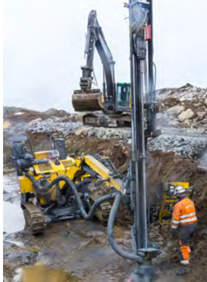
BETINGELSE: Når nødstoppsnorer erstatter vern skal det i tillegg iverksettes tiltak som hindrer personer å komme i kontakt med roterende deler. Eksempel: Skriftlige rutiner. (FOTO: JØRN SØDERHOLM)
