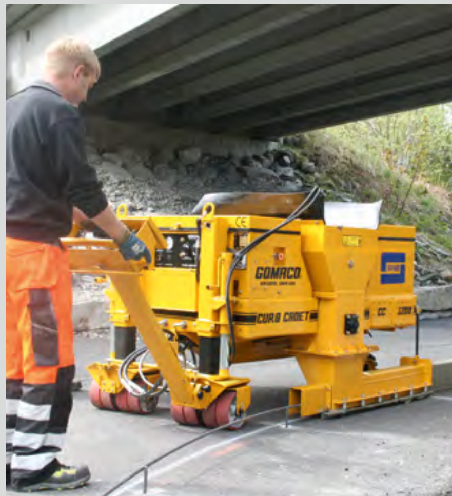
KOMPAKT: Selvkjørende kantstøp blir ikke mindre enn dette. I alle fall ikke fra Gomaco og Ankerløyken.
