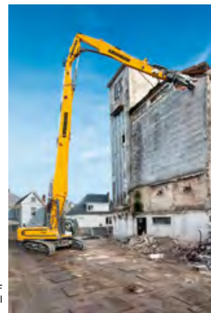
RIVER: Heftig rivningsmaskin på vei til AF Decom. Norges første Liebherr R960 skal bare innom Vei og anlegg først.
