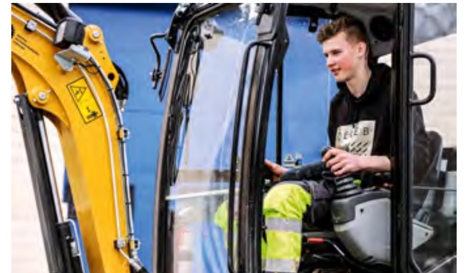
FORNØYD: – Det er veldig bra her. Mye bedre enn å legge belegningsstein på skolen, uten maskin, sier Emil Høyvik (17) i, der han sitter i OKAB-graveren og bygger mur.
