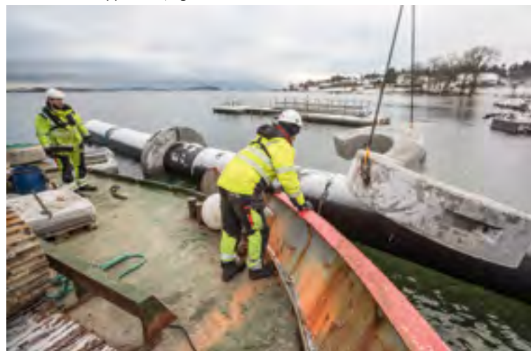
...de to delene smekker på plass rundt 1200-røret med ren tyngdekraft.
