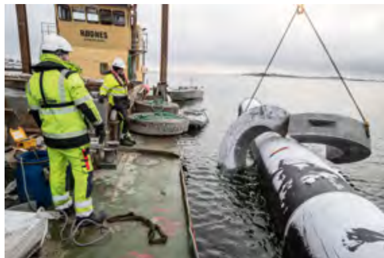
...de to delene smekker på plass rundt 1200-røret med ren tyngdekraft.
