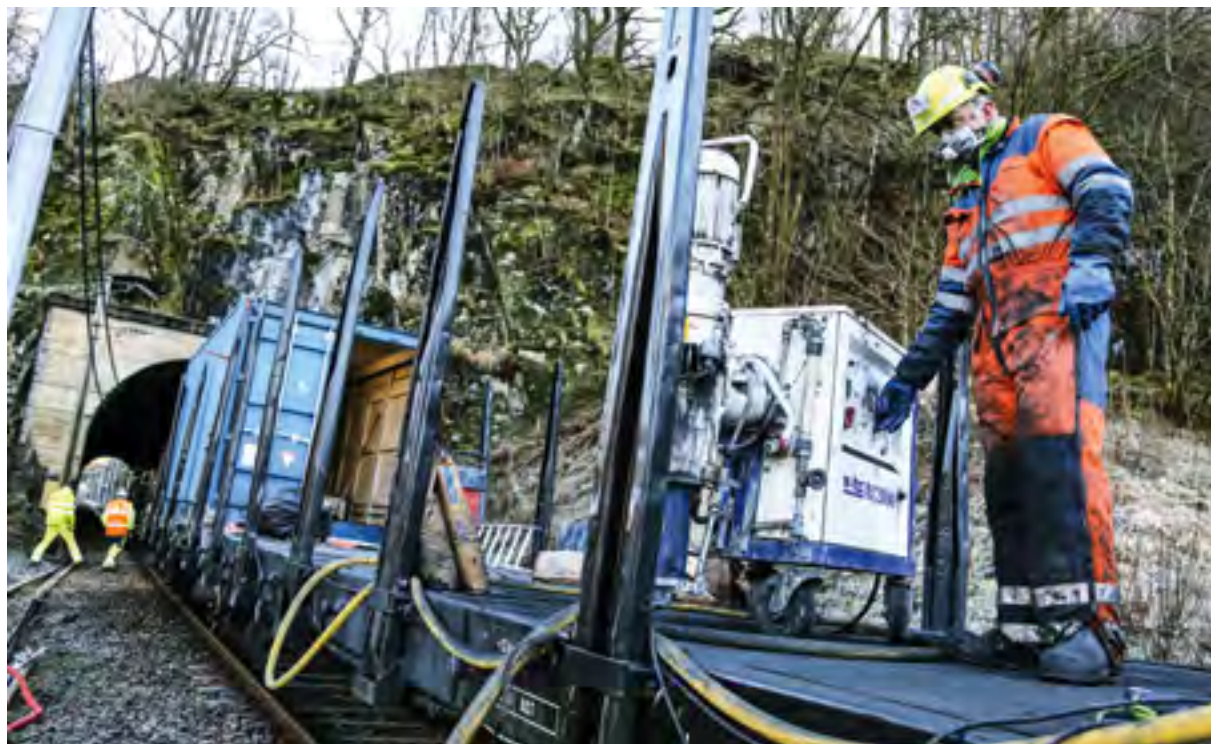
GYSEMASSE: Geir Johansen fra Grenland Betongsaging sørger for korrekt blande-forhold i gysemassen, en strømlerende elektrode-masse bestående av sement, kull og vann.
