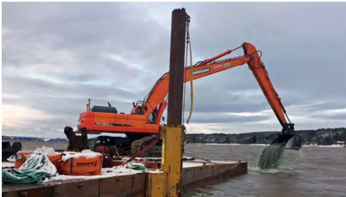
FLÅTE: En av to flåter i drift på Øyeren, med en 50 tonn Doosan. Flåten flyttes med en 200 hk truster (baugpropell) fra en slepebåt, drevet av graverens hydraulikk.
