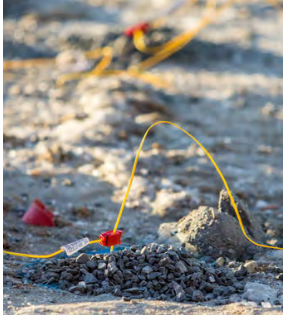
SIKKERHET: Noen ønsker krav om elektroniske tennere på all sprengning. Det kravet vil ikke Statens vegvesen oppfylle.
