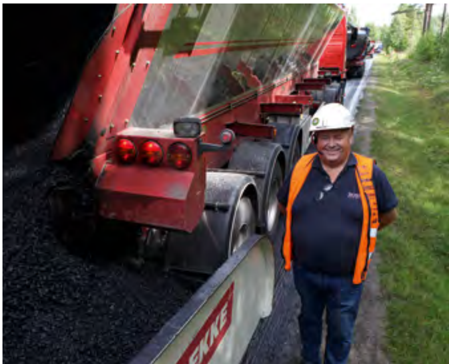
Her er Per Arne Lunn ved Red River-bilen. Denne bilen, uten tipp, mater asfalten opp i troa automatisk med transportbånd i bunnen av kassa, og ved hjelp av fotocellen som vi ser oppe til venstre i bildet.
