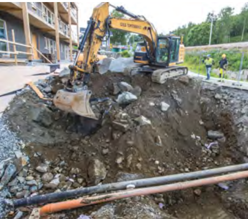
FOLK: Ofte er det folk i grøfta under maskinene. Da er det viktig med størst mulig sikring mot at skuffa faller.
