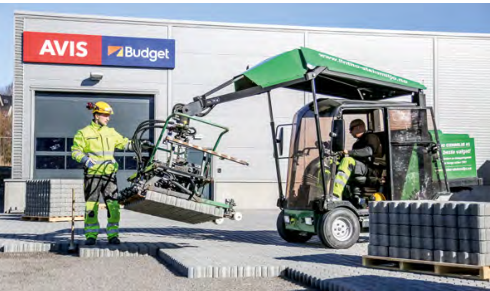
1. EFFEKTIVT: Maskinell steinlegging går unna. Det tar fire minutter å legge ut en pall med steiner, som er ca. 8 kvadratmeter og veier til sammen 1650 kilo.
