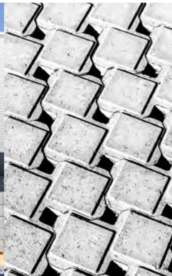
2. FINJUSTERING: Adrian Mróz banker litt på steinene med en gummislegge for å få det helt nøyaktig.
