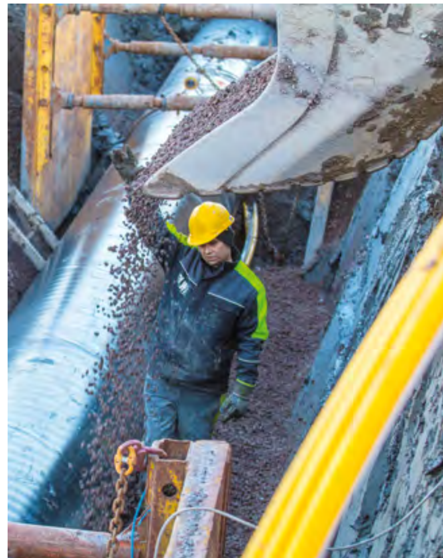
RISIKO: Konsekvensene ved å miste skuffer og annet utsyr fra gravemaskinene, kan være store, som det dessverre er mange eksempler på. (Foto: Jørn Söderholm).
