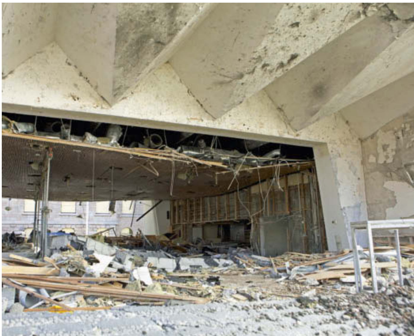
Kaos Det er bokstavelig talt mye å ta tak i for PeWe Entreprenør (Foto: Statsbygg).
