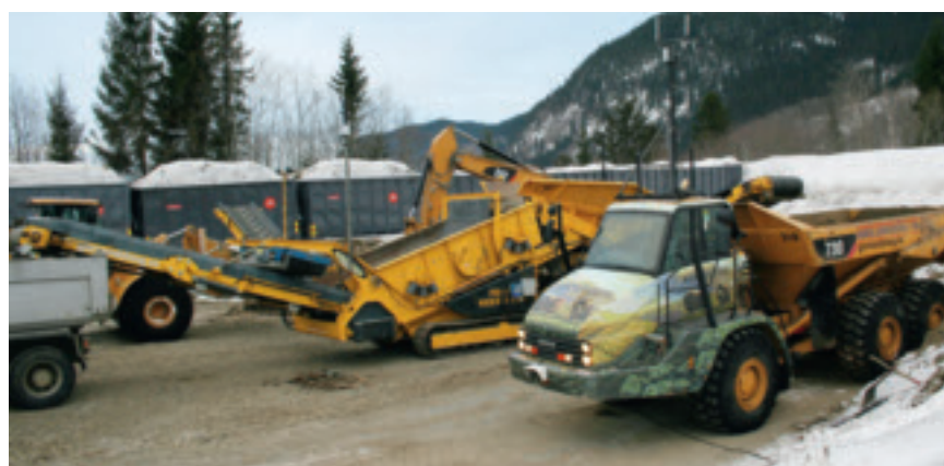
Spøkelsesmaskiner Alle maskinene – dumper, gravemaskin og sorteringsverk – er førerløse og styres fra containeren flere hundre meter unna.
