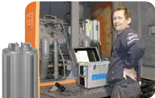
BPU montert på Hitachi ZX 870H-3 hos Bjønndalen Bruk AS
