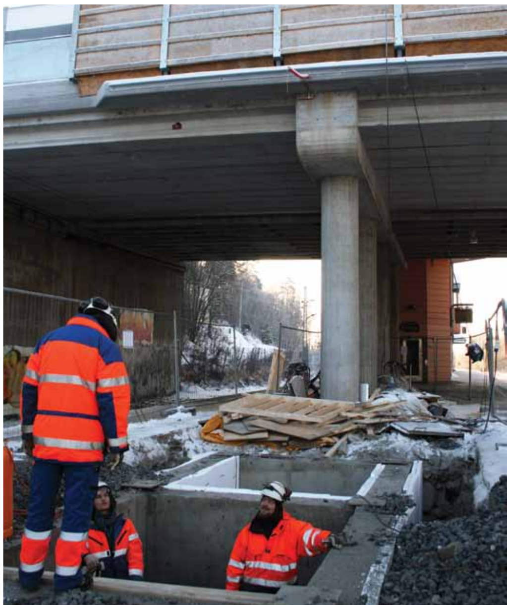
Heissjakt Anleggsleder Magnus Magnusson i samtale med Patrick Broughton (venstre) og Espen Thorkilsen (alle fra TKS-Bygg), som står nede i heissjakt. Det nye trappehuset vil lede reisende opp til broen ovenfor, der det er montert midlertidige treplater.
