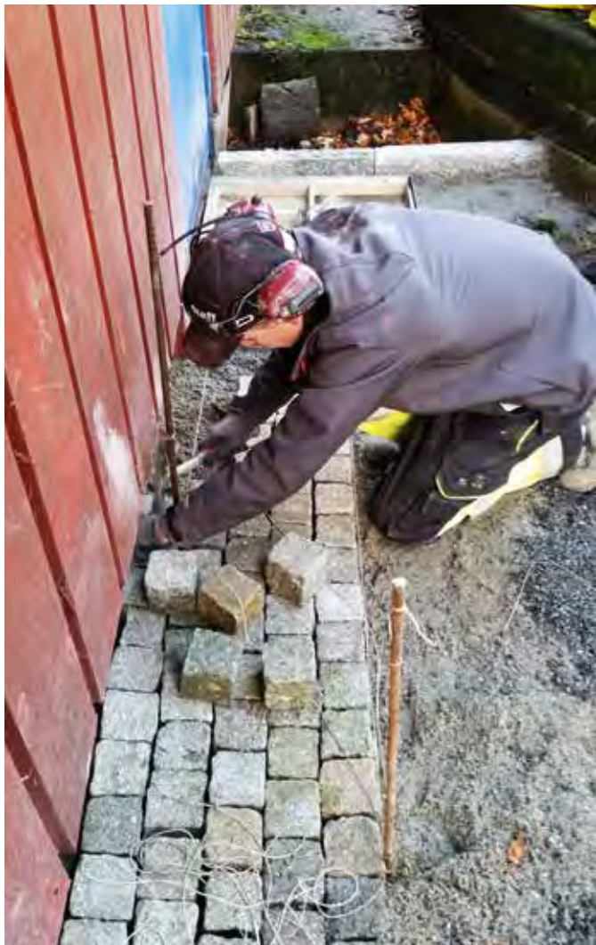
BROSTEIN: Endre Botnevik lager smågatesteinsrenne utenfor stallen. (FOTO: STIAN EIKEVIK).
