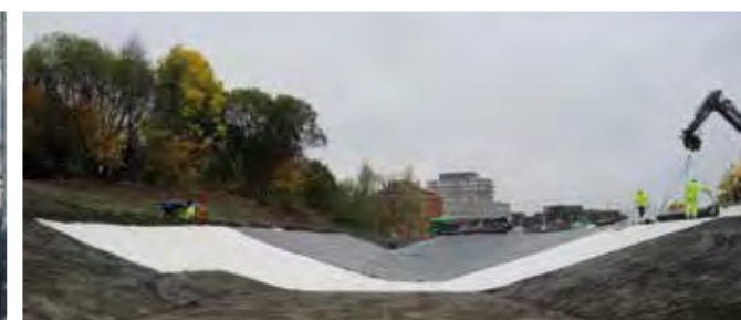
Membranarbeider - Teglverksdammen - Oslo
