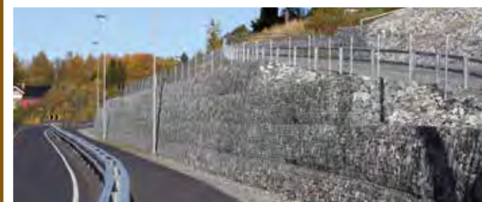
Gabioner med jordarmering - Fetsund
