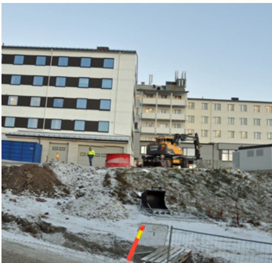
KLARGJØRING: Her på Hammerfest sykehus skal det bores fem energibrønner. (FOTO: SVEIN G. JØRSTAD)
