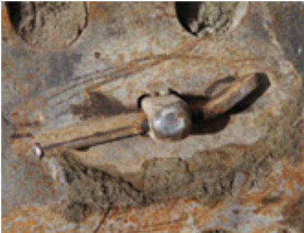
FERDIG: Stålet på skjæret er festet med kiler gjennom kilebolter.
