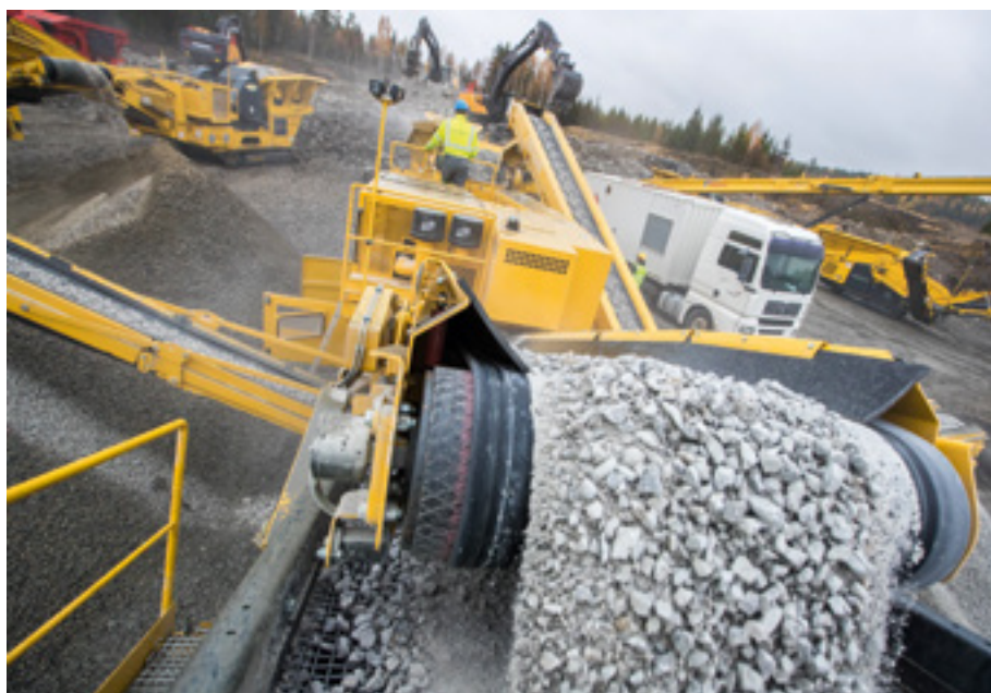
GENERATOR: Hele knuseoppsettet drives av en 500 kVA generator på den hvite lastebilen t.h.
