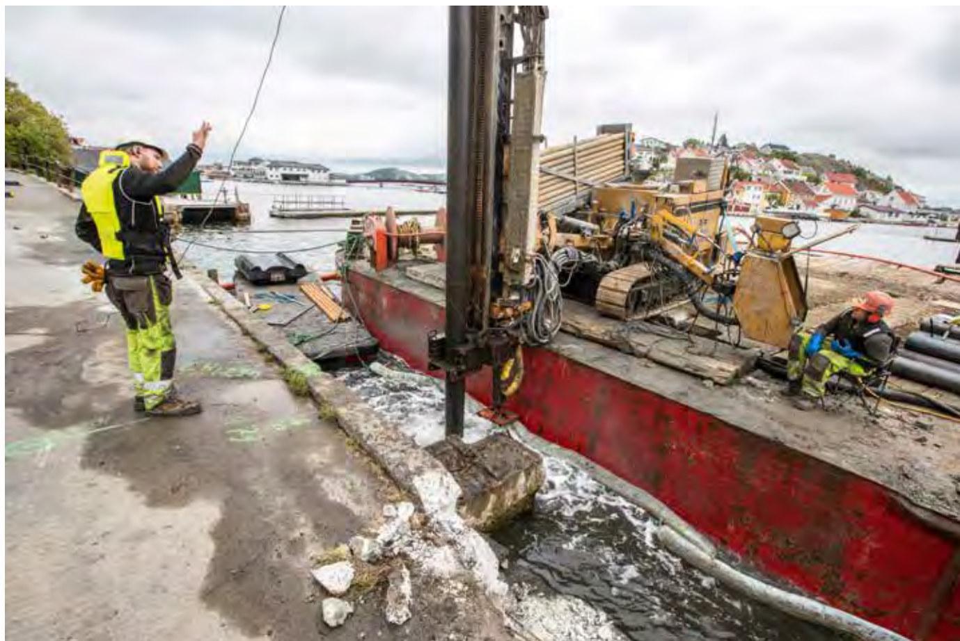
KAIFRONT: Andreas Steinsholm anviser borevinkel til operatør Kjetil Larsen. Gema 55 boreriggen er plassert på en leker, på et komplisert prosjekt med pæling av en ny kaifront i Kragerø havn.
