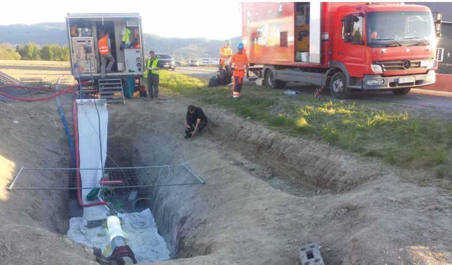
KAPASITET: Den rehabiliterte vannledningen i Sande mistet kun 3,4 prosent i diameter (fra 250 til 241,4 mm). (FOTO: KJELDAAS AS)
