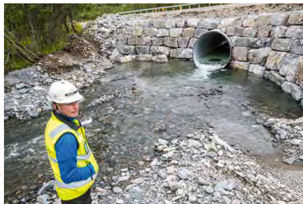
STOLT: Arvid Thomassen er anleggsleder for Anlegg Nord på prosjektet RV 94 Skaidi-Arisberg. Han er også faren til Svein Arvid Thomassen (20), som har bygget denne muren rundt stikkrenna under RV94. (FOTO: JØRN SØDERHOLM)
