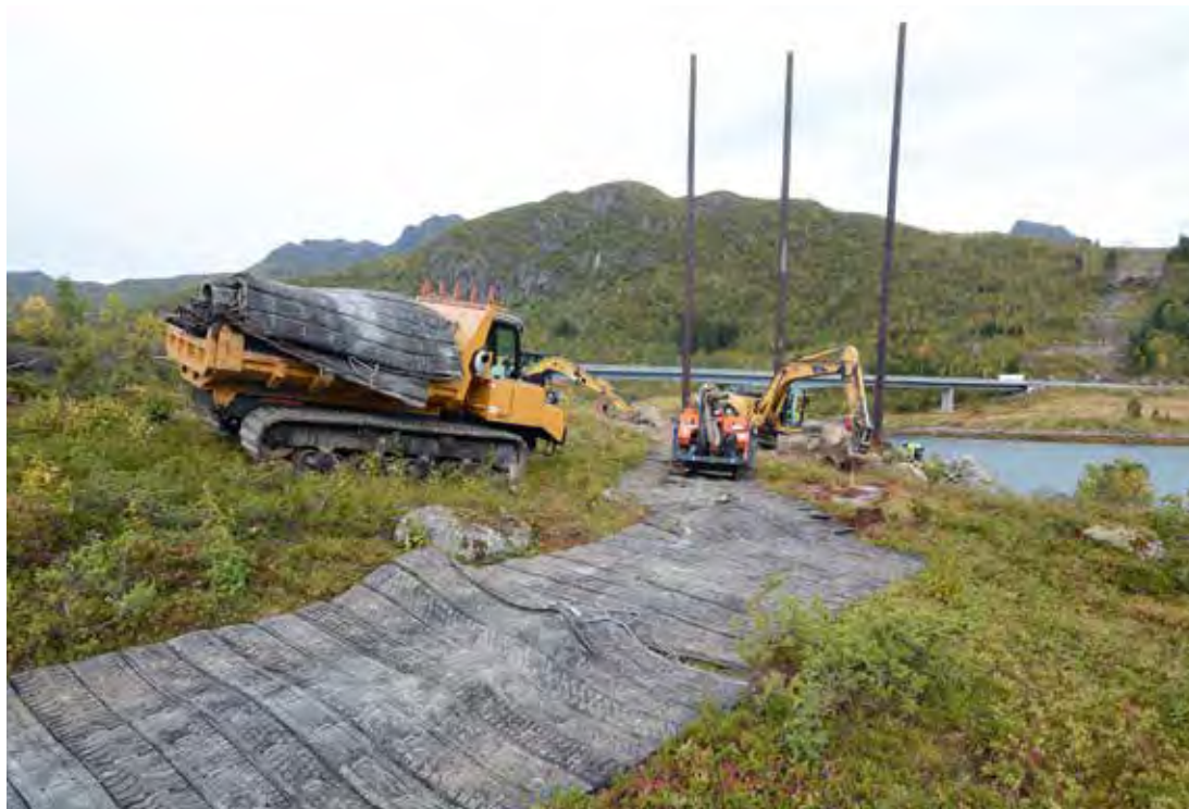
SPRENGINGSMATTER: Det er strenge krav til inngrep i terrenget i traséen. Så her har det gått på gummisåler.
