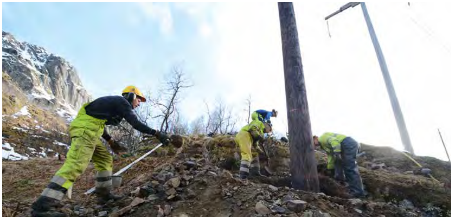
MANUELT: Stein lempes tilbake i det 2,5 meter dype hullet for å stabilisere stolpen.
