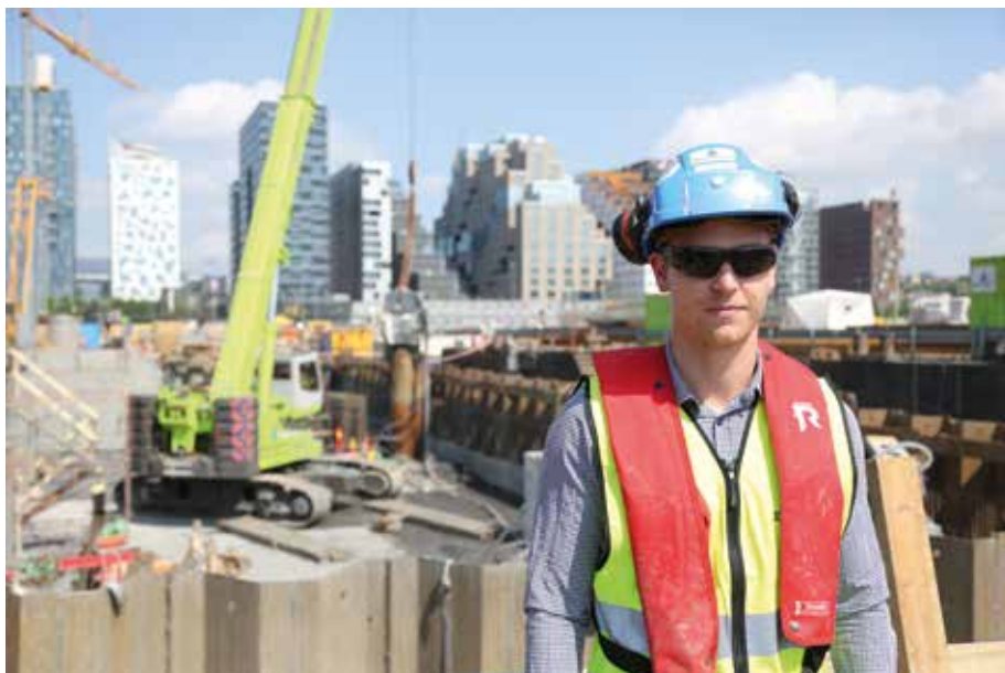
SPENNENDE: Marius Østberg Olsen, prosjektingeniør hos Kynningsrud Fundamentering, synes det er gøy å være med på dette store, komplekse og spesielle prosjektet.
