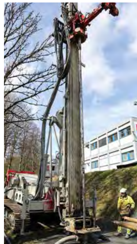
KRAFTIG: Comacchio MC30-riggen er mye større enn vanlige borerigger. Den veier 36 tonn og kan ta 12-meters borestrenglengder.
