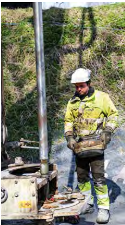
HAR STYRING: Borebas/anleggsleder Jonas Hansen trekker opp borestrengen ved hjelp av fjernstyring. 308 meter borestreng må opp for å skifte borkrone.
