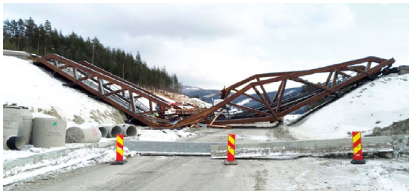
BRUA KNAKK: En beregningsfeil under prosjekteringen førte til at limtre-brua kollapset på E6 i Gudbrandsdalen.
