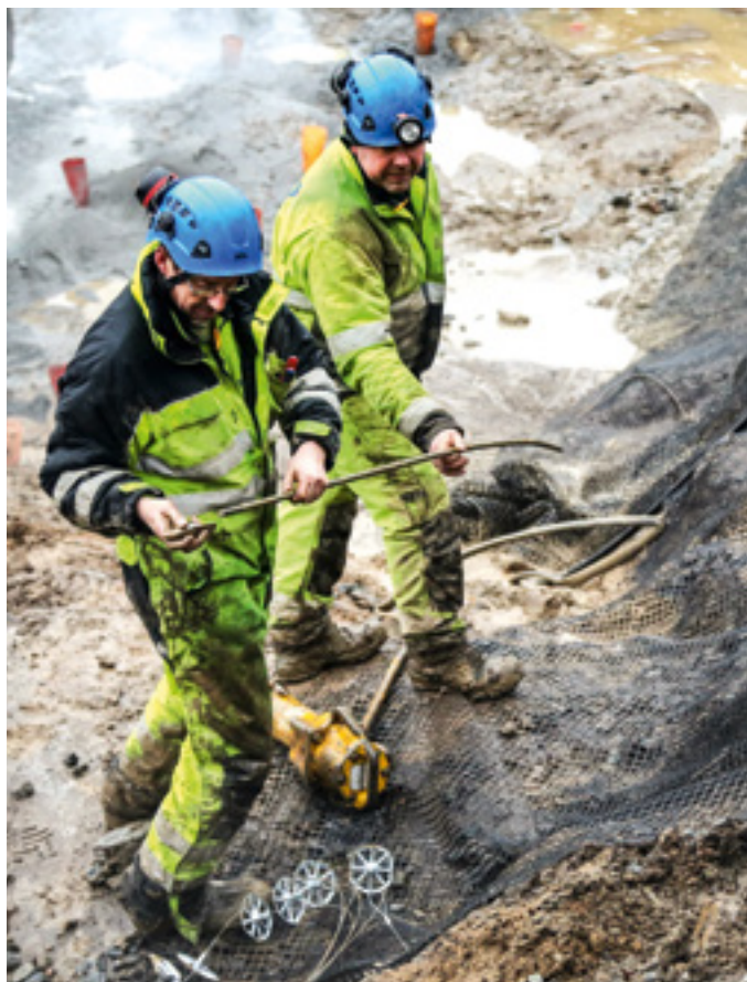
ENKELT: Her festes endestykket til stanga, før den bankes inn i løsmassene.
