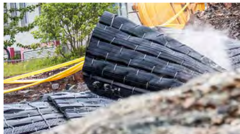
SALVE: Sprengning i tettbygd strøk utført av en person med blodferskt sertifikat. Er det en god idé? Salven på bildet er ikke omtalt i saken. (FOTO: JØRN SØDERHOLM)
