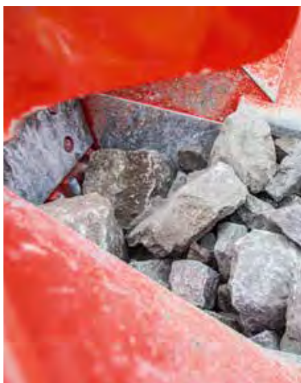
CE-PLIKT: Materialer som er tilført byggeplass er CE-pliktig, uansett om det er betalt eller ikke. (FOTO: JØRN SØDERHOLM)
