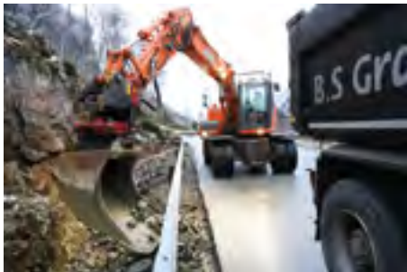
NYE MASSER Deler av asfalten er fjernet fordi vannet har tatt med seg massene under. Nå skal det komprimeres fra bunnen av igjen med gode masser før det asfalteres på ny. Her fyller Vidar Egeli på med pukk.
