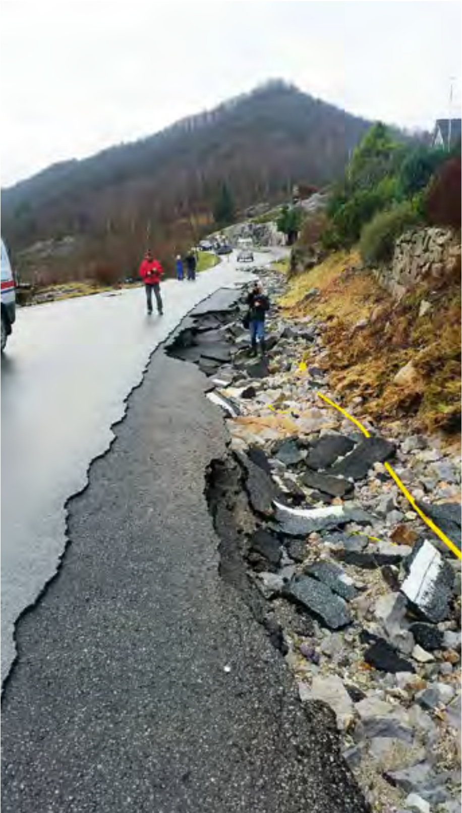
NYE MASSER Deler av asfalten er fjernet fordi vannet har tatt med seg massene under. Nå skal det komprimeres fra bunnen av igjen med gode masser før det asfalteres på ny. Her fyller Vidar Egeli på med pukk.
