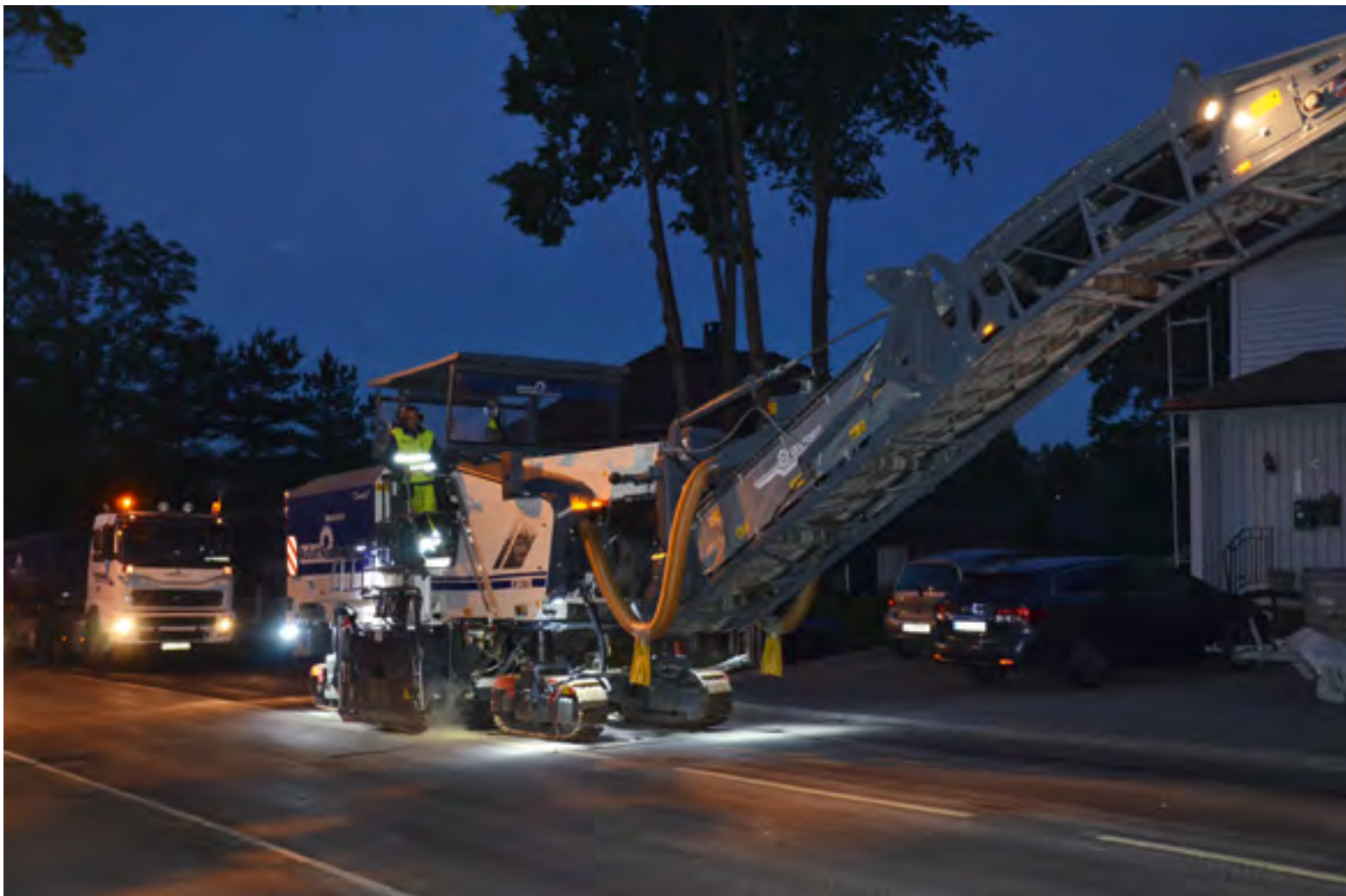
PRISING: – De forlanger at vi skal varme opp asfalt før den freses. Asfaltvarmere har ikke vært i bruk i Norge de siste 20 årene, men det har ikke byggherrer eller konsulenter fått med seg, sa Brynildsen. Her fra et oppdrag Asphalt Remix AS har i Moss. (FOTO: ODD BORGESTRAND)
