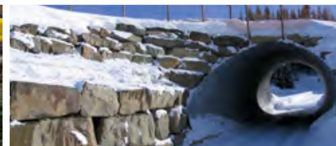
MP 200 flerplaterør som skiundergang - Hafjell
