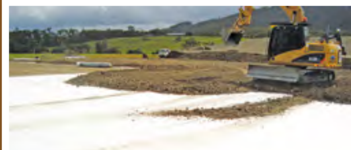
Fiberduk til separasjon
