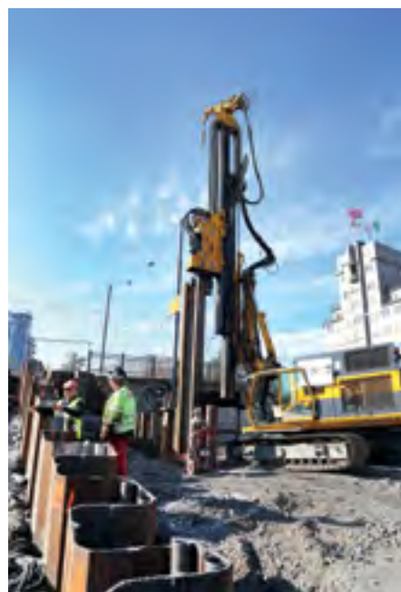
JAGGED WALL: Denne spuntveggen har et motstandsmoment på hele Wx 6000. Det er kraftig kost.
