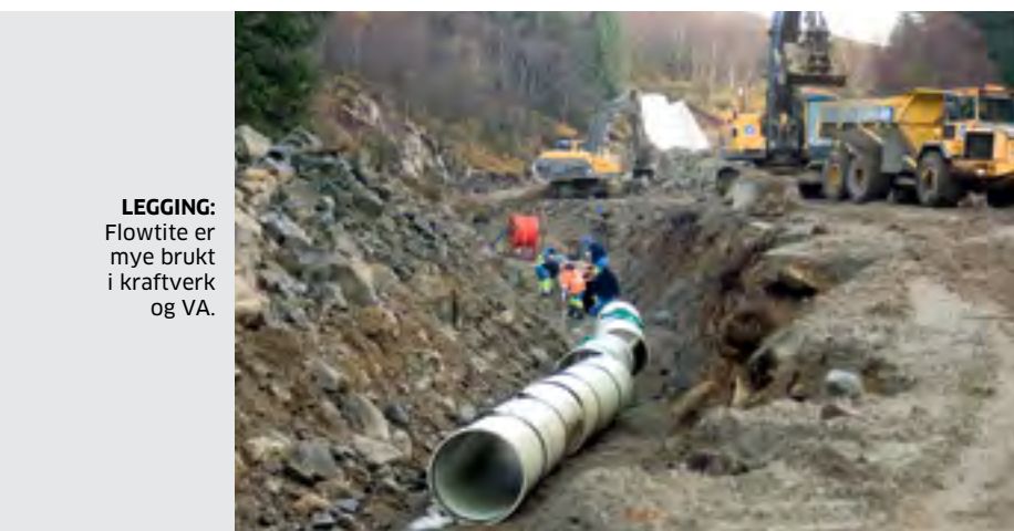
RØRGATE: 114 år gamle DN 1100 stålør i to løp ble erstattet med ett løp DN 1400 og 1600 i GRP. (FOTO: AMIANTIT NORWAY AS)
