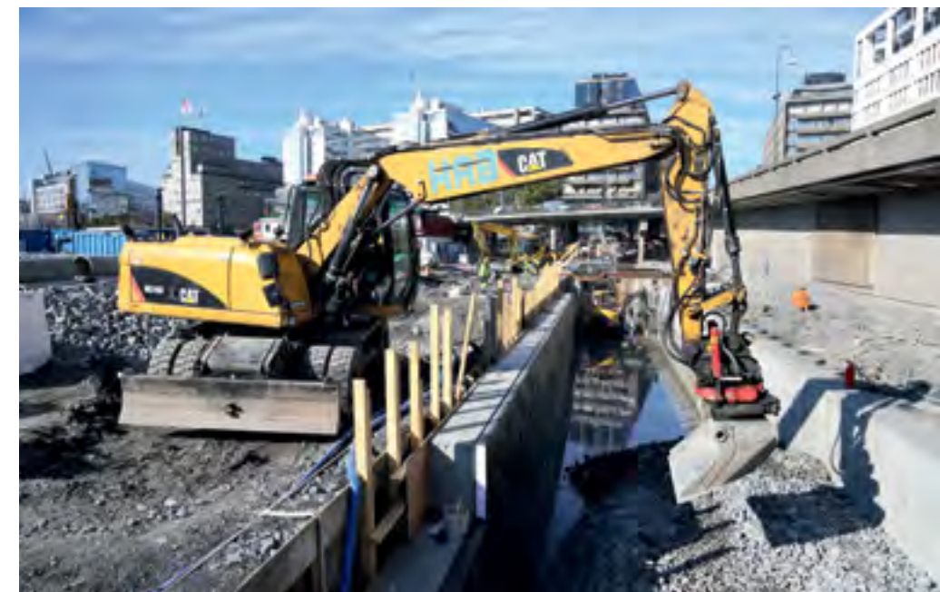
BETONGTRAU: Dette er deler av grunnarbeidens første etappe. Her skal det legges VA- og fjernvarmeledninger for det nye museet
