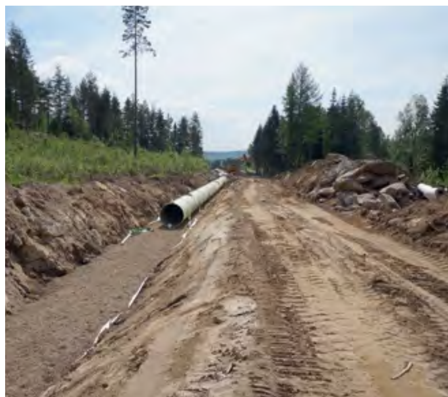
RØRGATE: 114 år gamle DN 1100 stålør i to løp ble erstattet med ett løp DN 1400 og 1600 i GRP. (FOTO: AMIANTIT NORWAY AS)
