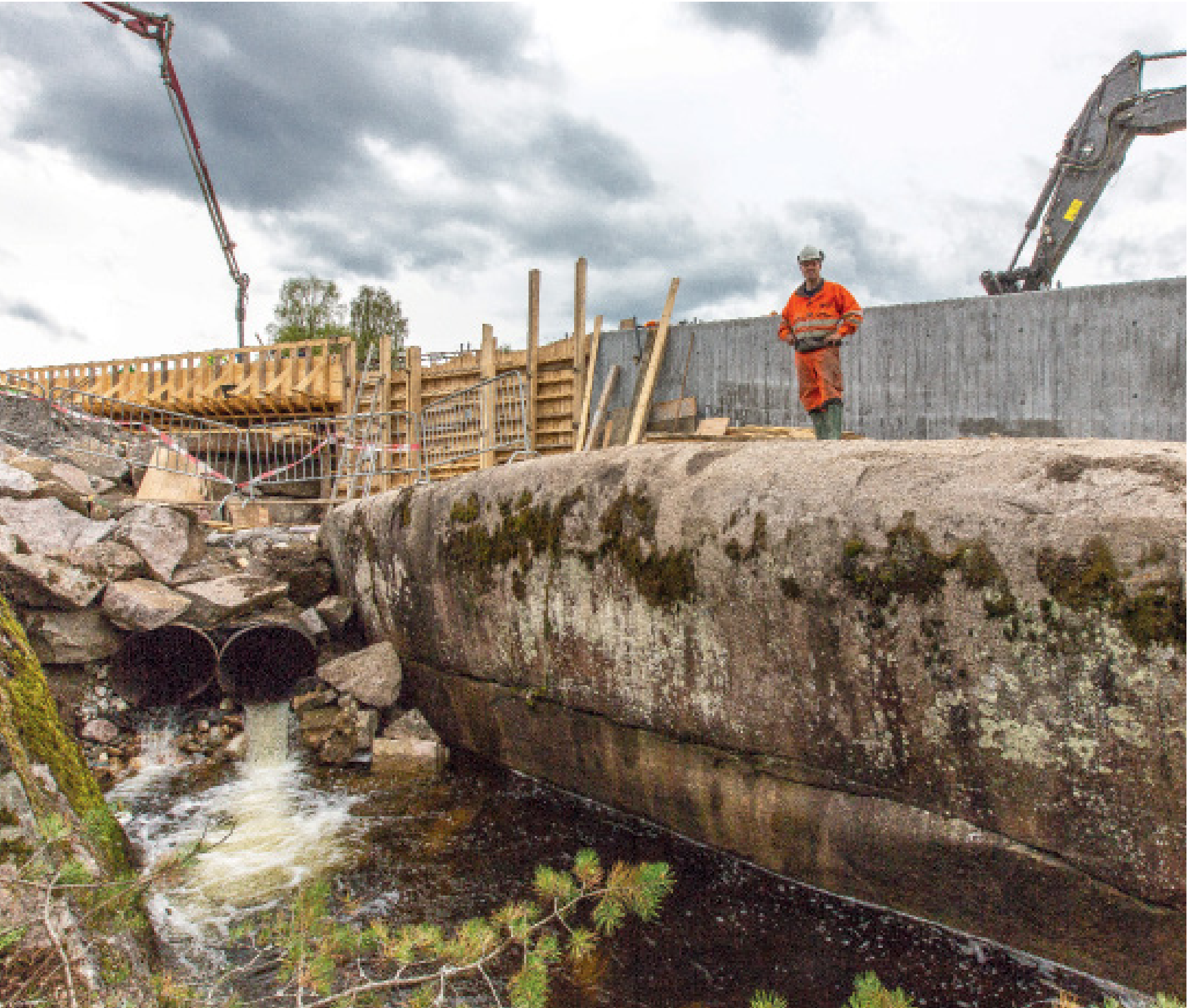
ANLEGGSELEDER: Erlend Solheim syntes det var greit å legge elva midlertidig i rør, og bygge form til brua på fyllinga.
