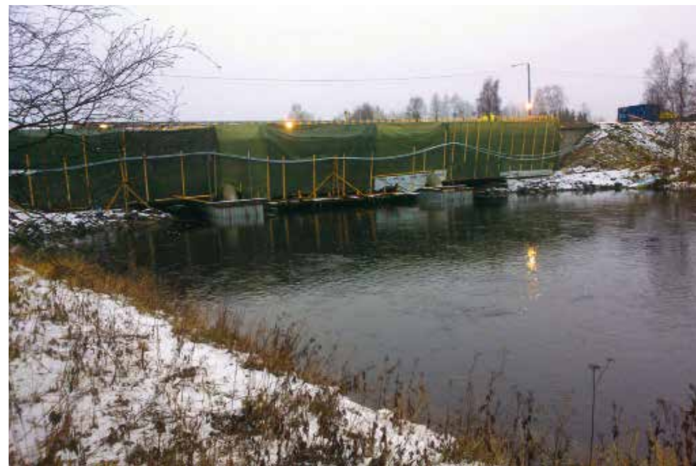
BROBYGGING: 600 kvadratmeter betongbro ble støpt i finske Oulu.
