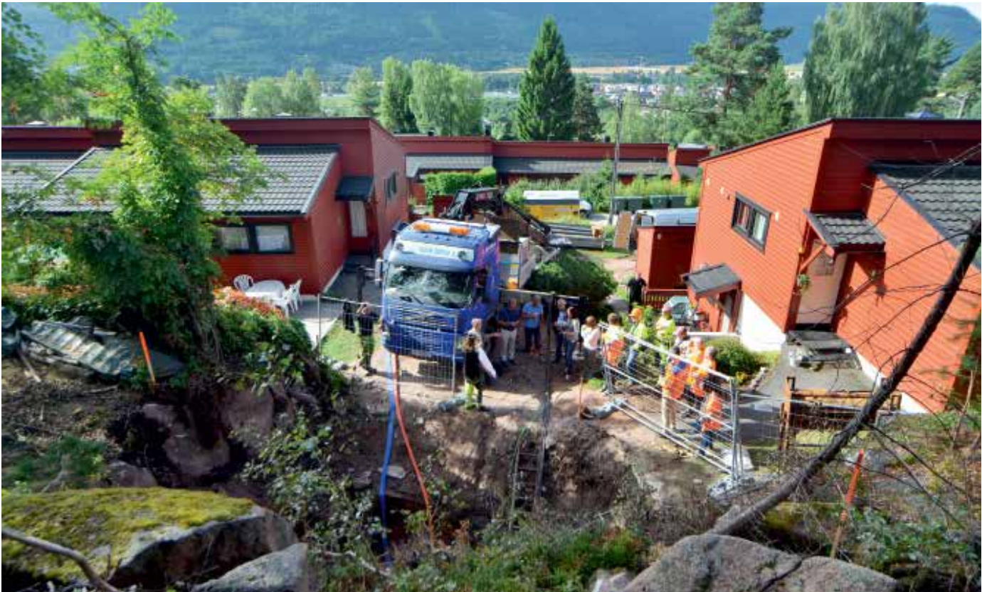
GRAVING: Borettslaget Brøttet fikk et nytt, felles rørsystem med minimal oppgraving.
