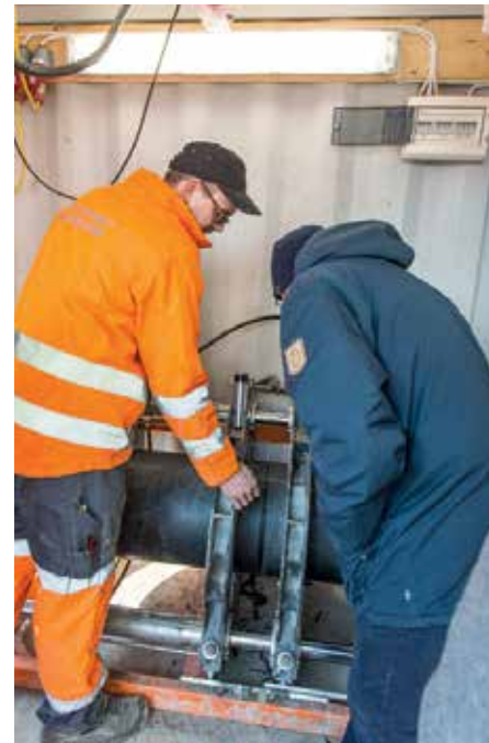
SVEIS: Demonstrasjon av PE-sveising i en av Park & Anleggs sveisekonteinere.
