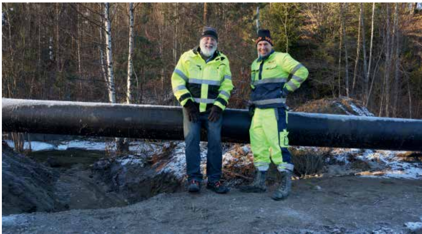
VENTER: Knut Schau Nielsen (tv) og Anders H. Dahlman venter på opprømming og inntrekking av den 250 meter lange DN400 PE-ledningen.
