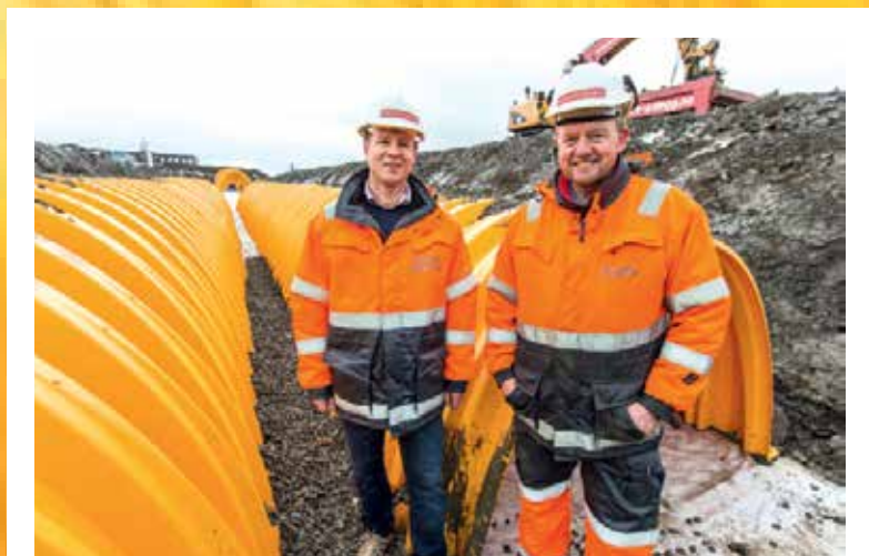
FØRSTE: Innkjøpssjef Simen Larssen (t.v.) og anleggsleder Helge Solbrekke i Park & Anlegg AS er fornøyd med selskapets første bygging med det amerikanske systemet.
