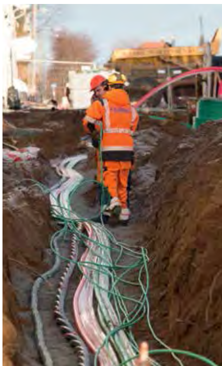
MILDØ: Høstens og tidligvinterens milde klima gjorde godt for framdriften i Nansetgata. Anleggsrørlegger Kim Aleksander Holt og Jannik Floberg Andersen legger trekkerør i grøfta.
