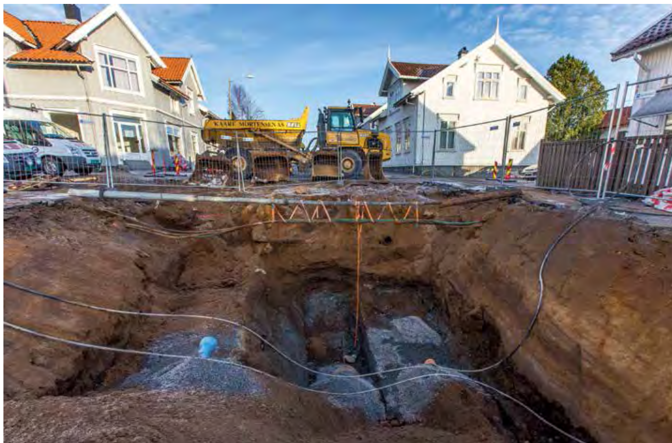
MILJØ: Nansetgata bygges om til miljøgate, og gammel infrastruktur skiftes ut. Kommunen betaler for jobben under traulet, Statens vegvesen for resten.
