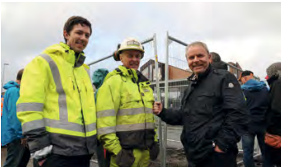
FORNØYD: F.v. Geir Henning Hansen i Asplan Viak Lofoten, Knut Skorta i Steg Entreprenør og Steinar Tragethon i Hallingplast var alle godt fornøyd over en vellykket rørinstallasjon i Leknes.
