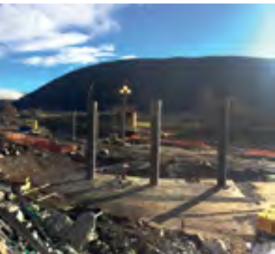
TUNNEL OG BRU2: Tre søyler på plass for den nye Kjørems bru, som blant annet går over toglinjen. Litt lengre bak er en provisorisk sikringstunnel for Dovrebanen under oppføring. (FOTO: E6 IMPLERIA - AURSTAD).
