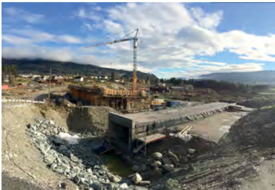
BRU OG KULVERT: Her bygges Hagastugu bru, som skal gå over den nye E6-en, samt en kulvert som skal lede vannet under E6-en. (FOTO: E6 IMPLenia - AURSTAD).
