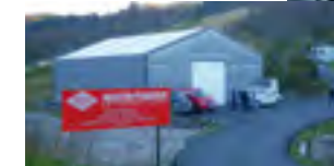
KLART: På Osterøy er det sprengstoff i bulk og patroner, samt lagermotell.
