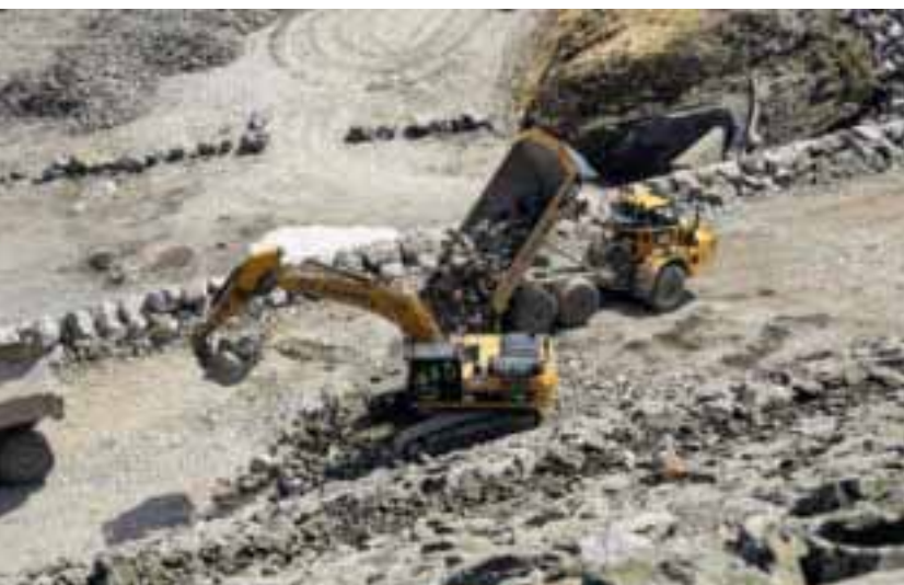
Stein Nok et lass med steinmasser blir tilført demningen.
