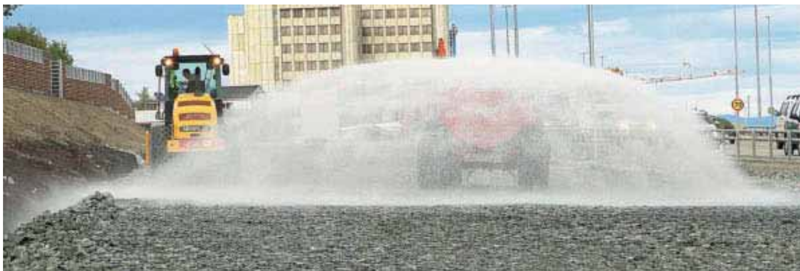
VANNES: En traktor sprer vann ut over pukken, før den komprimeres med valsetog.
