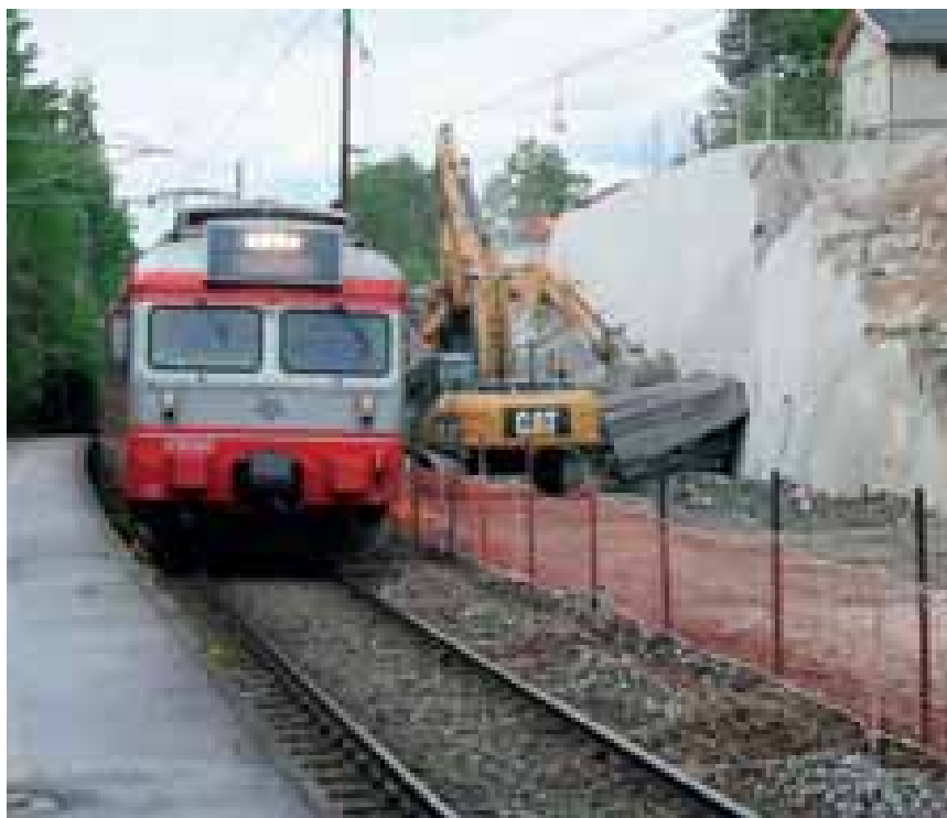
Hovedbanen Hanaborg stasjon får en ny og lenger perrong i retning Oslo, og jobben krever mye avansert utstyr med høy sikkefaktor blant tjuvpakket.
