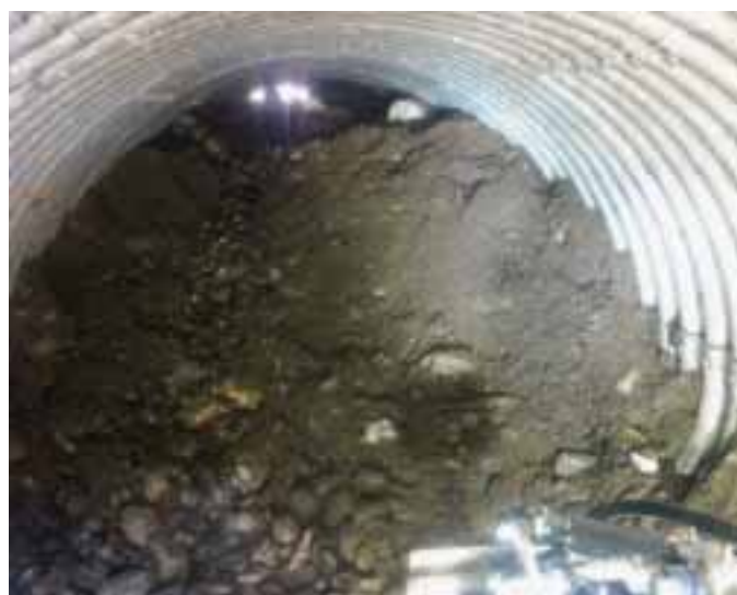
PAKKET: Kulvertene er solid pakket av sand og stein etter flommen.
