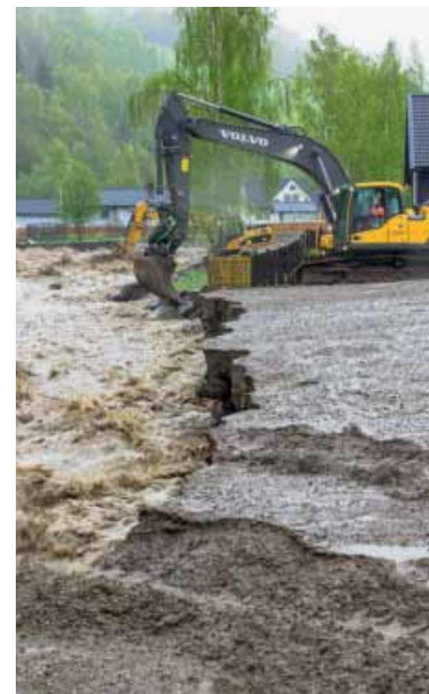
PLASTRING: Mange tusen kubikk med stein gikk med i intense plastringsforsøk for å prøve å bremse elvas herjinger.
