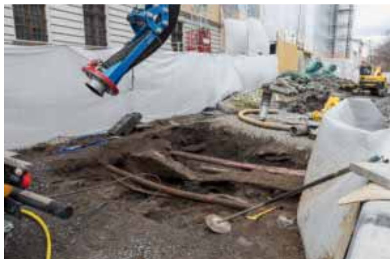
KABLER: Gravemaskinførerens mareritt er grei skuring for vakuumsugeren. Kabler og rør blottlegges enkelt og skadefritt.
