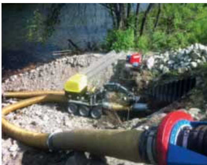
MINIGRAVER: En selvgående, fjernstyrt minigraver er koblet rett på sugeslangen.
