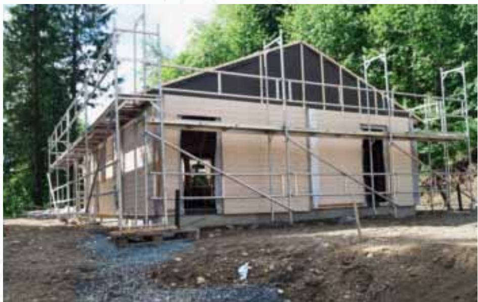
Grunnarbeidene for bygget er selvsagt utført av elevene på anleggsteknikk.
