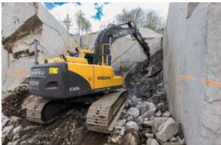
VOLUM: Totalt 7 000 kubikkmeter fast fjell sages, skytes og løftes ut.
