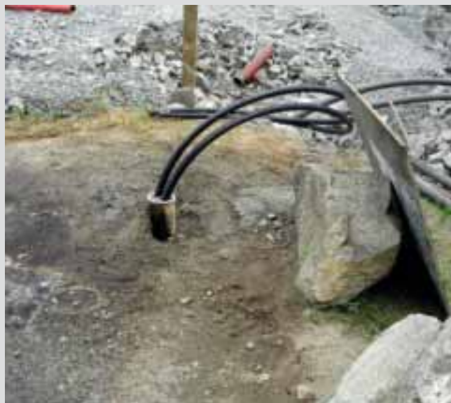
ENERGIBRØNN: Enova gir mer i støtte.
