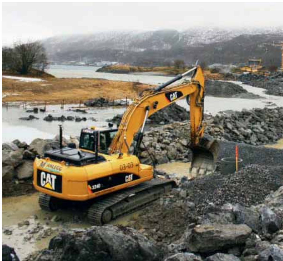
Hektisk Arbeidene pågår for fullt, her anlegges veien på Løding-siden av den nye brua.
