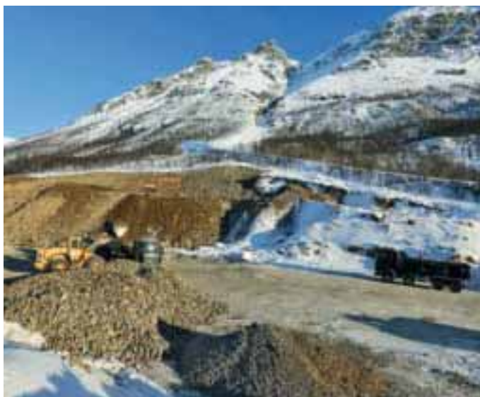
UTTAK: Masseuttaket på Hestvolla blir fangrop for ras når jobben er ferdig.
